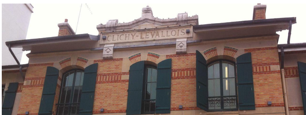
[Fig.5/ Gare de Clichy-Levallois ©Cerema]
