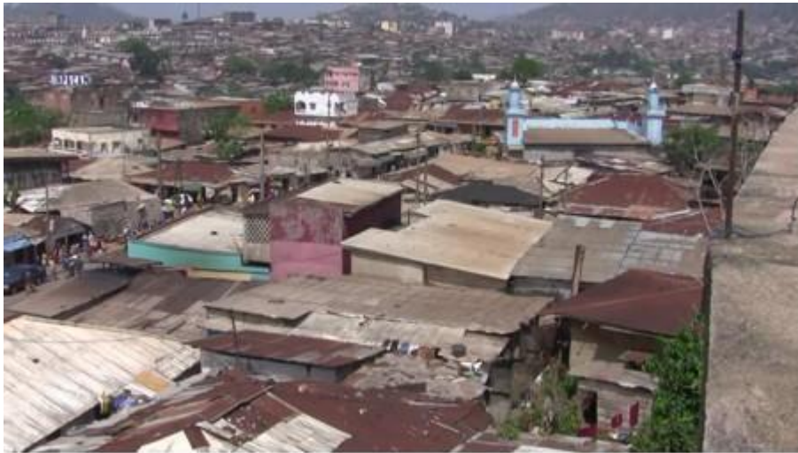
Photographie 3. La Briqueterie, Yaoundé : la densité des habitations au service du contrôle social Auteur : S. Fer (2009)
