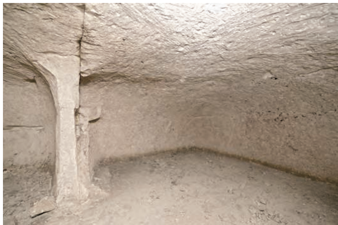
Fig. 33 – Chouilly La Grifaine. Hypogée 6. Vue de la deuxième chambre (salle 3). La diaclase est à l'origine de l'effondrement d'une partie du mur et de la tablette. Photo R. Martineau.
