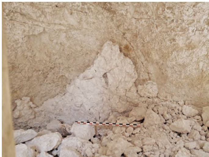
Fig. 56 – Chouilly La Grifaine. Détail de la couche carbonatée pulvérulente adhérente à la paroi de l’hypogée 9. Photo S. Thiol.
