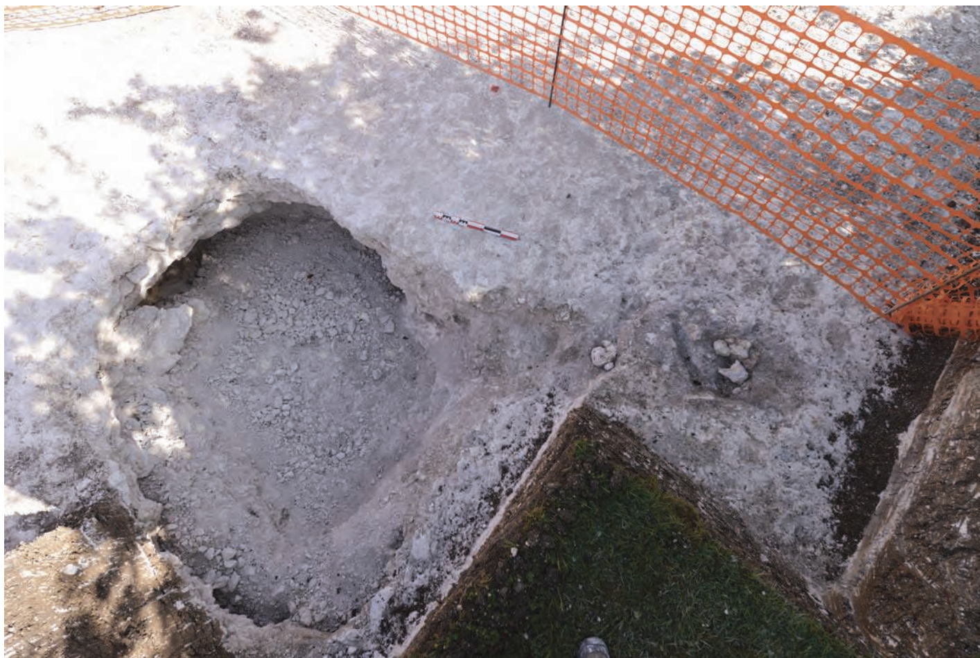
Fig. 52 – Chouilly La Grifaine. Vue zénithale du couloir d'accès et de la chambre effondrée de l'hypogée 9. Photo R. Martineau.
