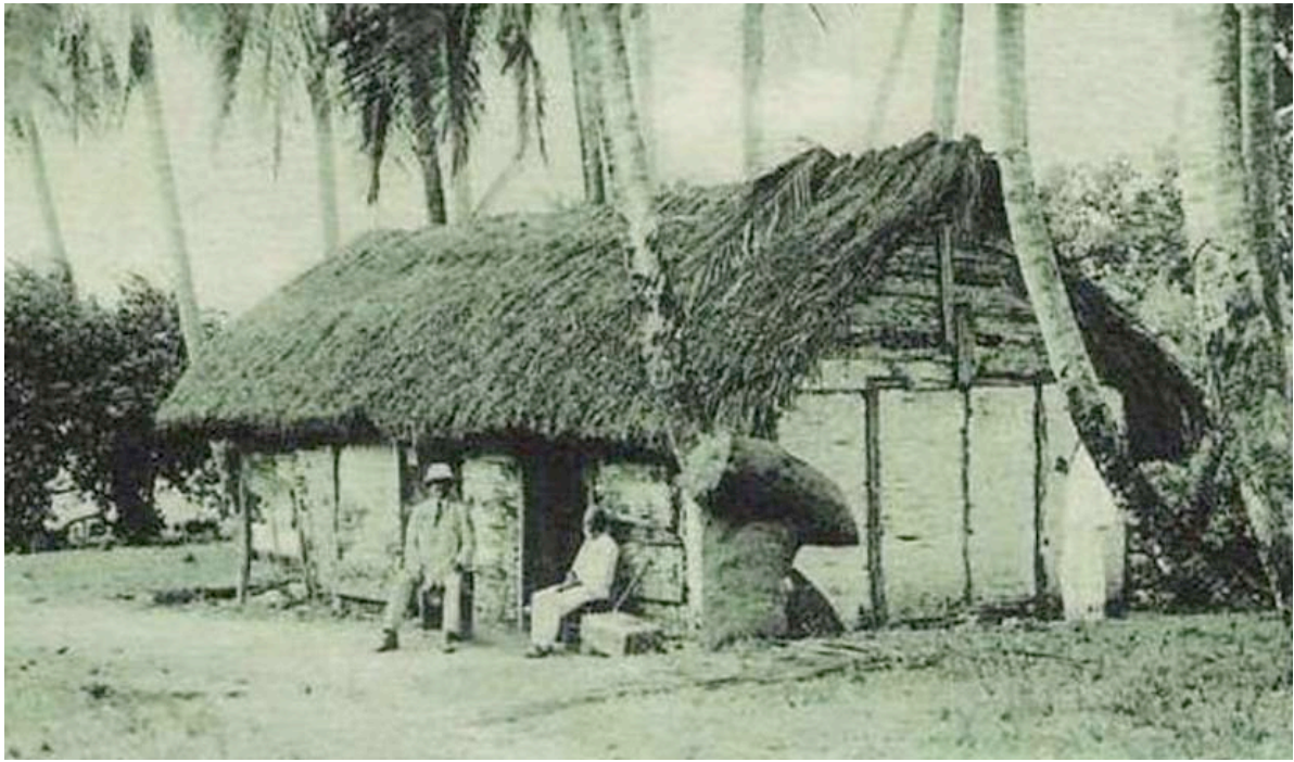
Figure 3. Case en galettes enduite de torchis, à l'Anse à l'Ane (Martinique). Source : Coll. Part.
