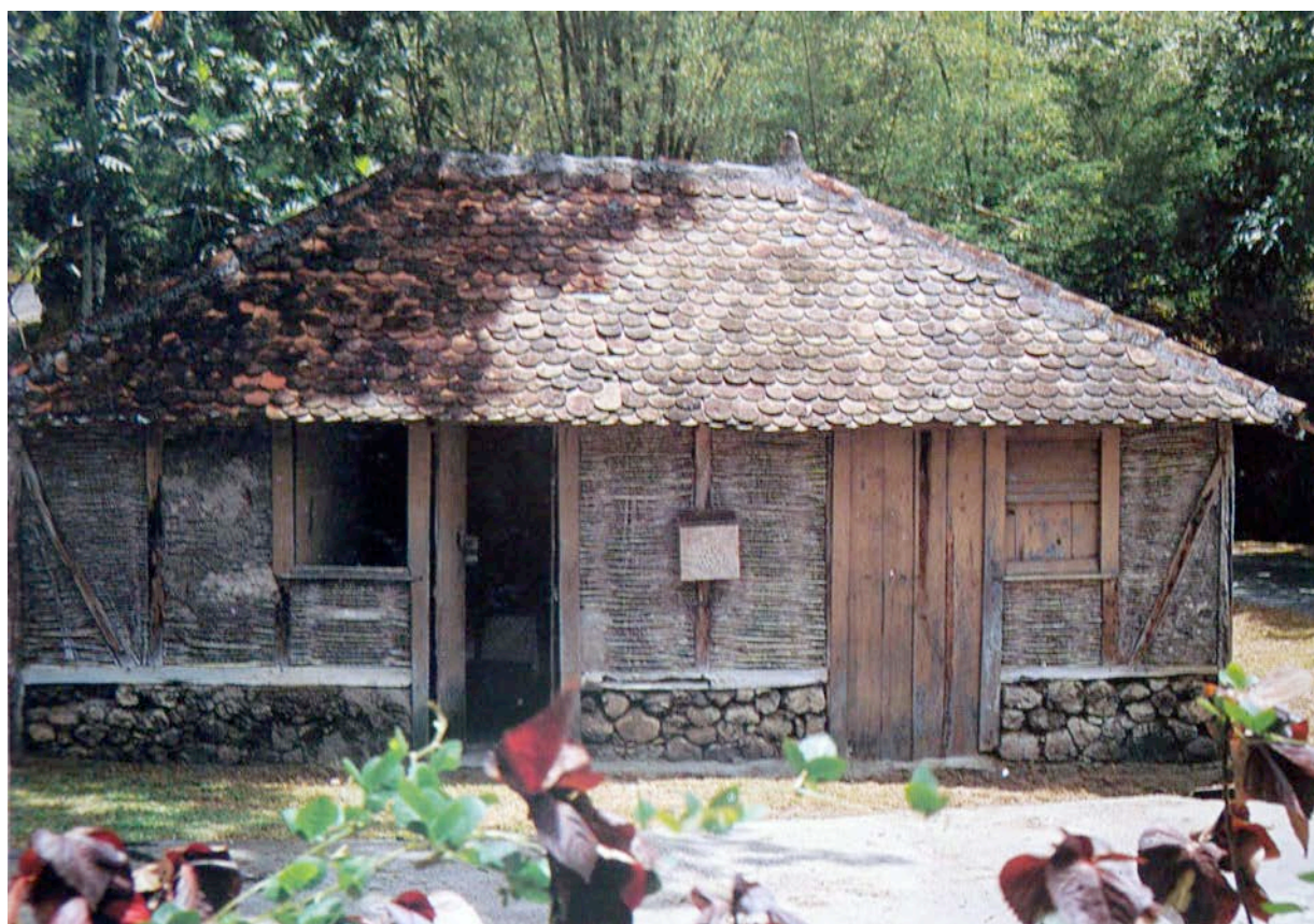
Figure 7. Case en gaulettes couverte de tuiles écailles, soubassement en maçonnerie. Source : Coll. Part.
