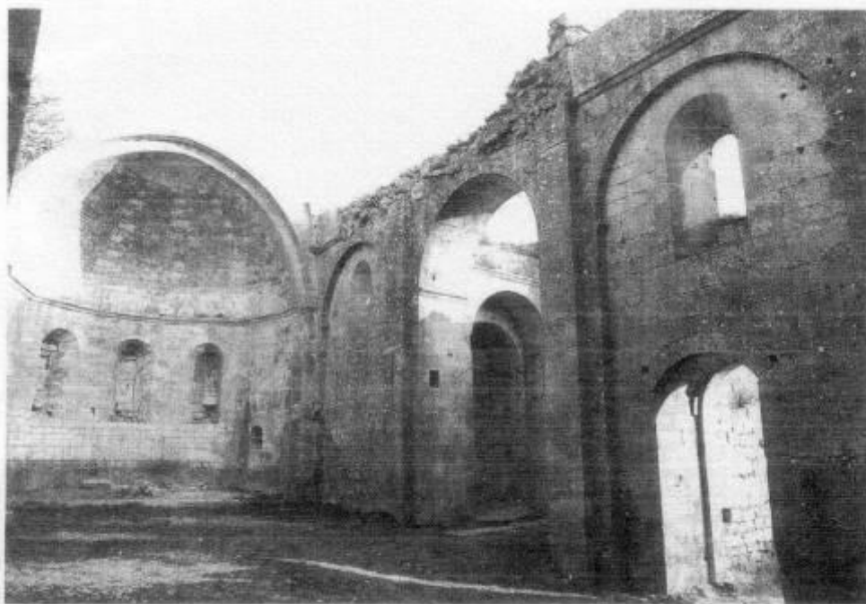
FIG. 5. — INTÉRIEUR DE LA NEF, DU CROISILLON SUD ET DE L'ABSIDE, VERS LE SUD-EST
