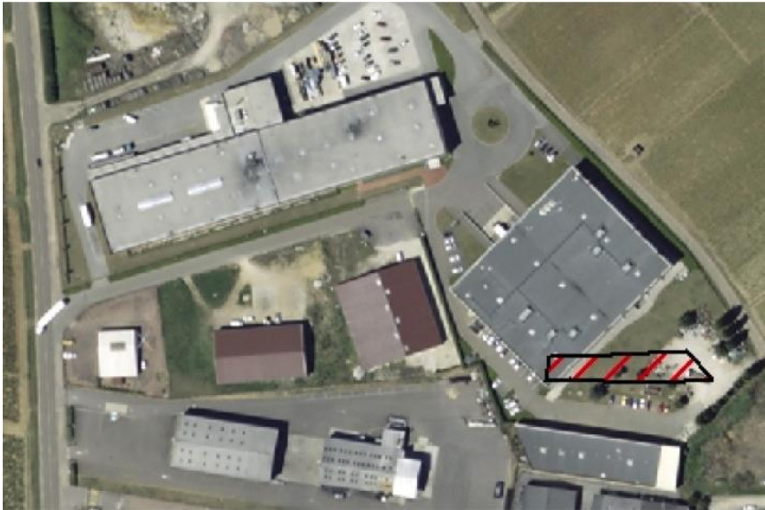
Figure 5 – Parcelle de terrain (en hachures rouges) non affectée par les exploitations des gravières et l'aménagement de la zone d'activité de Beaune-Savigny-lès-Beaune depuis 1962
