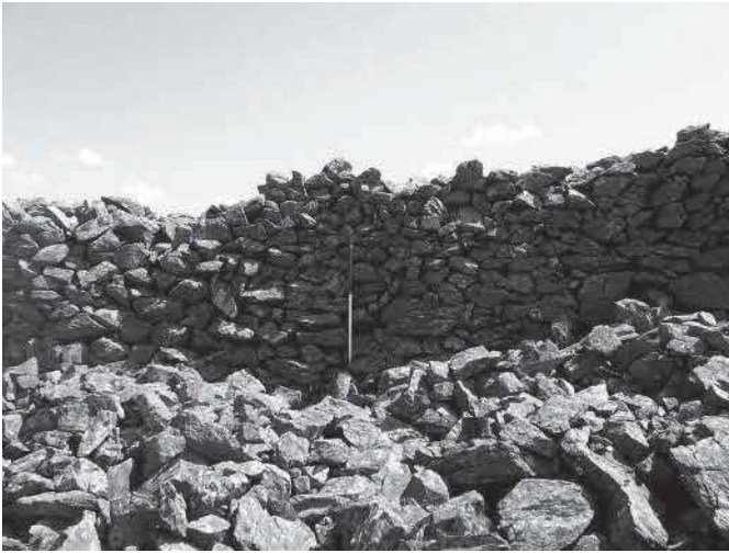
Fig. 4 : Vue du parement externe du rempart (Cliché F. Delrieu).
