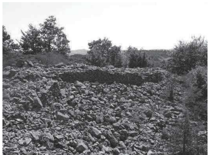
Fig. 3 : Vue d'une section du rempart depuis l'extérieur du site (Cliché F. Delrieu).
