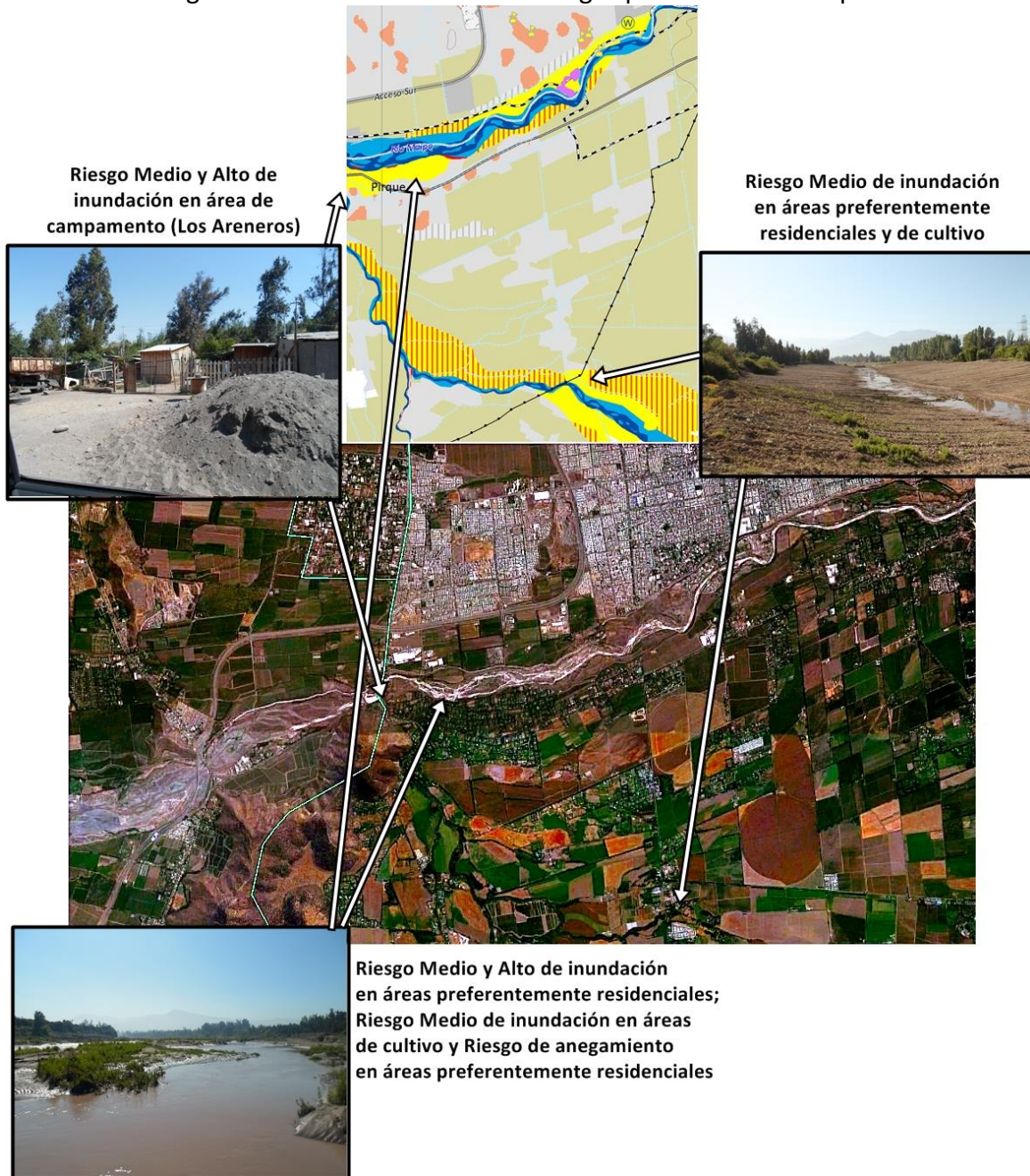
Figura 42. Puntos relevantes de riesgos potenciales en Pirque
