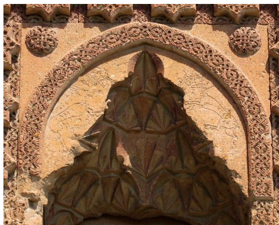
Fig. 23. Éghvard. Ste-Mère de Dieu. Façade Ouest. Portail du niveau intermédiaire. Cerfs sur les bords de la niche à stalactites. Photo P. Donabédian.
