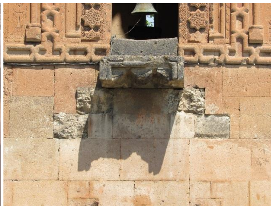
Fig. 8. Éghvard. Ste-Mère de Dieu. Porte du niveau intermédiaire. Seuil saillant et début d'escalier suspendu. Photo P. Donabédian.
