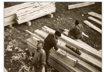
Les charpentiers sur le chantier de la cité des Castors à Bressuire (Deux-Sèvres), vers 1955. Photo M. Revereault.
