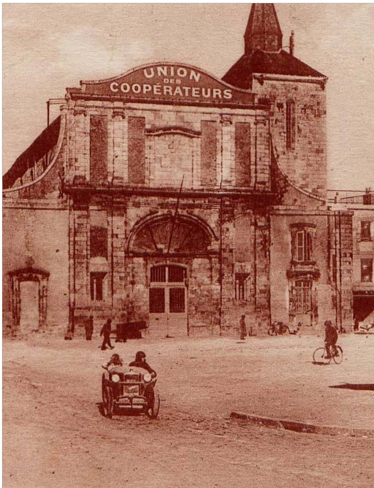
L'Union des coopérateurs de La Rochelle et ses environs, créée en 1916, avait installé ses entrepôts et les bureaux de son siège social dans l'église désaffectée de Saint-Nicolas (non loin de la gare, actuellement hôtel Ibis). Elle comptait alors 4 000 sociétaires et une vingtaine de magasins. © Fonds Camille Robreau, Archives municipales de La Rochelle, 5 Fi 4295.
