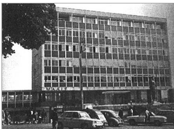
Bâtiment de la MAAIF, dans les années 1970. Archives de la MAIF.
