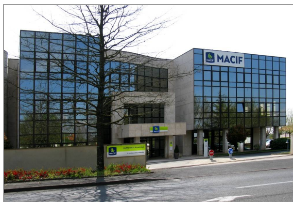
MACIF, 35 boulevard Jean-Moulin et 13 rue Thiers à Niort.
