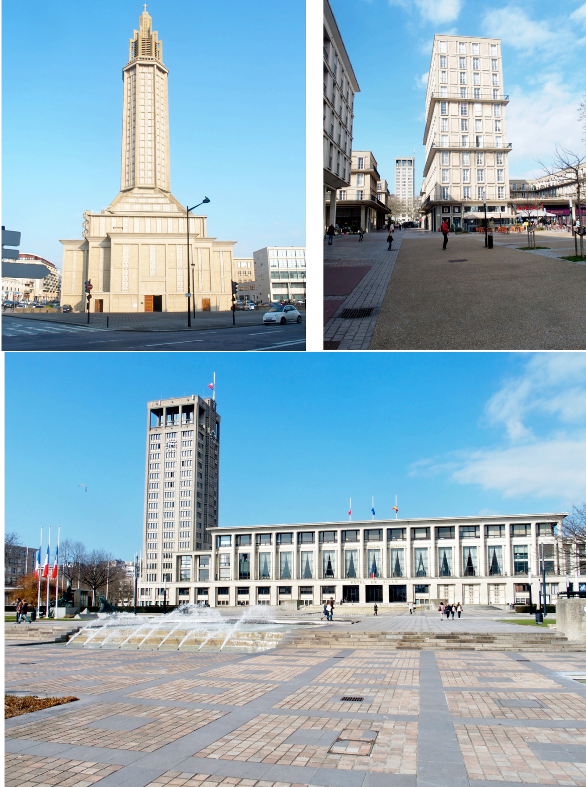
Figure N°8-9-10 : Les bâtiments d'Auguste Perret classés monuments historiques
