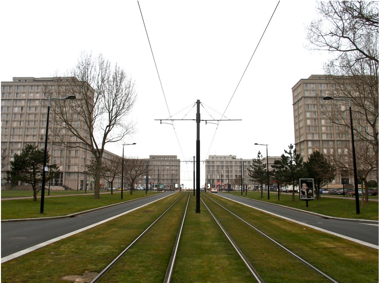
Figure N°5 : Le passage de la nouvelle ligne de tramway avenue Foch
