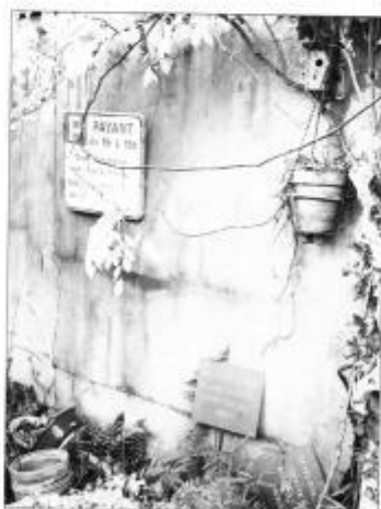
APRÈS LES TRAVAIL: L'ancien mur de briques a été peint, vieilli et décoré de panneaux diversifiés.
