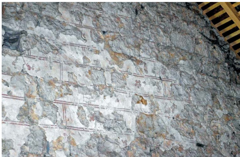
Fig. 9 - Détail de l'enduit peint du mur pignon sud. Cliché C. Roms, INRAP.
