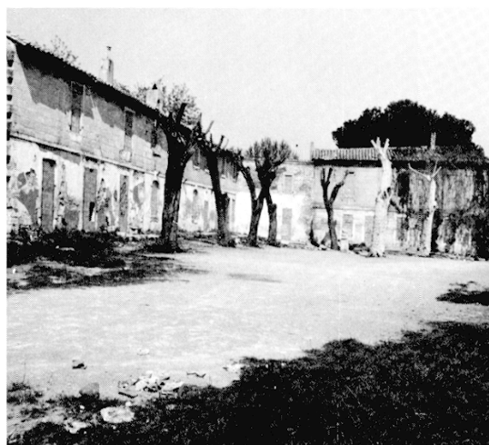
Fig. 3 - Vue d'ensemble des corps des bâtiments B et C prise de l'Ouest (document inventaire ; cliché Roucaute-Heller).
