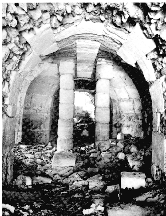
Fig. 6 - Intersection des deux couloirs de tirage (document inventaire ; cliché ROUCAUTE-HELLER).
