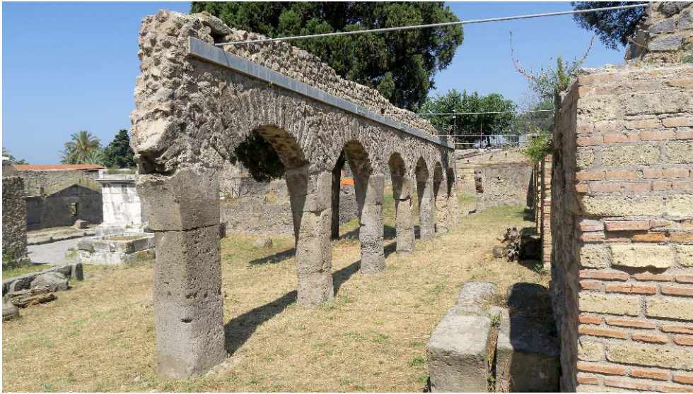
Fig. 7 – Arcade du portique en correspondance des boutiques N25-27.
