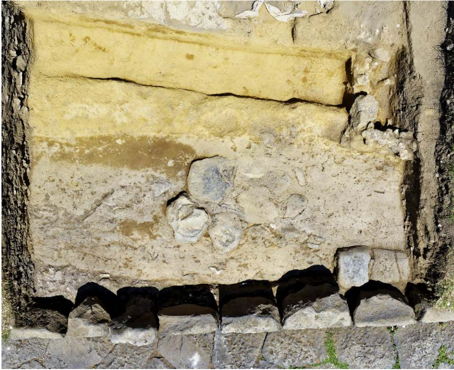
Fig. 10 – Vue zénithale de la voie dallée interceptée entre le portique et la via dei Sepolcri devant la fontaine N20a.
