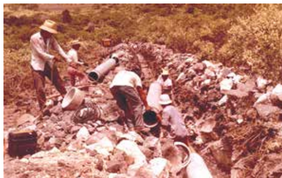
Imagen 1 - CF-1103-33798 – Trabajadores colocando la tubería en la línea de conducción del manantial Chihuahuita a Xoxocotla, agosto de 1975, municipio de Tlaltizapán, Morelos.
