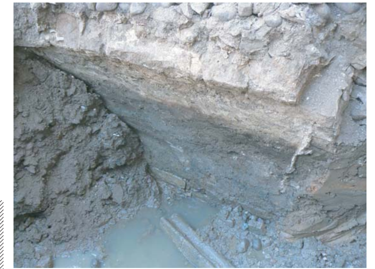
fig.5 : vue du mur I.241 et de la voûte I.242 depuis le sud-ouest
