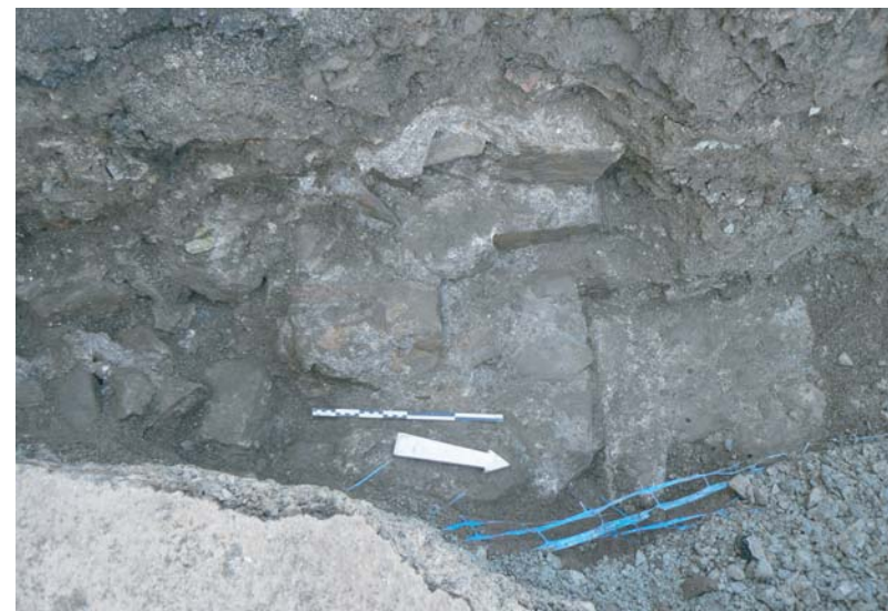
fig.2 : vue du MUR I.238 depuis l'est
