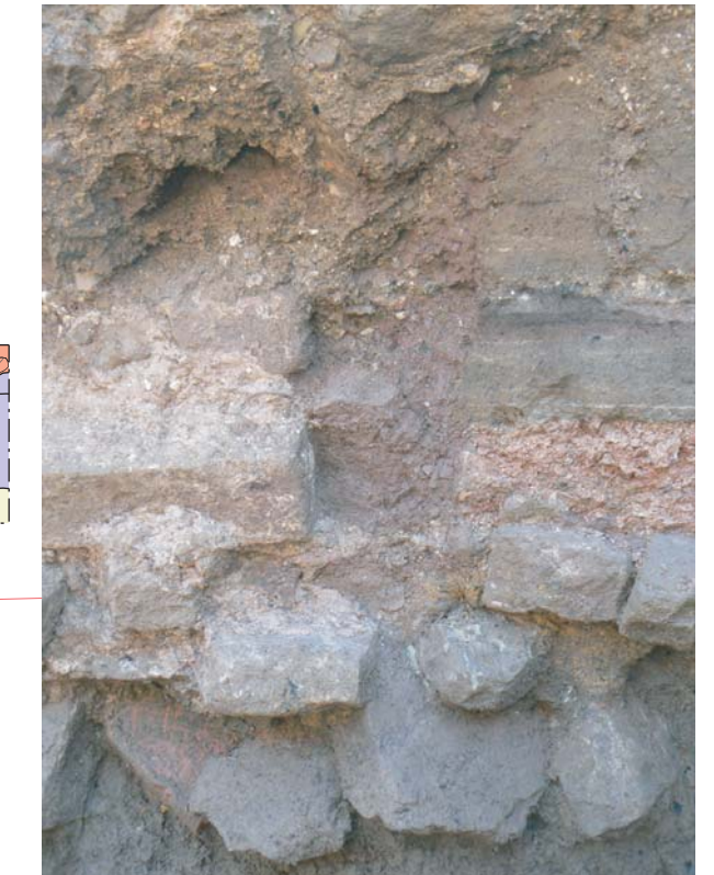
fig.3 : détail de la tranchée II.245 coupant le sol II.243
