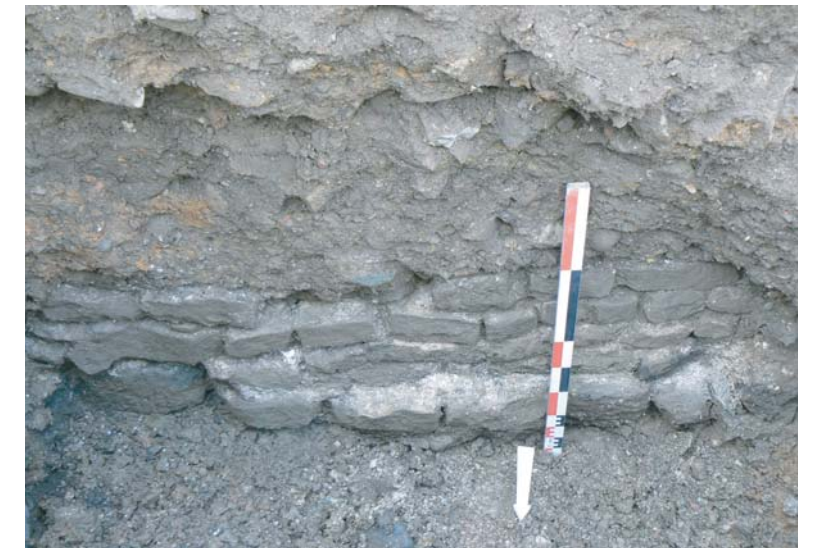
fig.4 : vue du MUR I.218 depuis le nord
