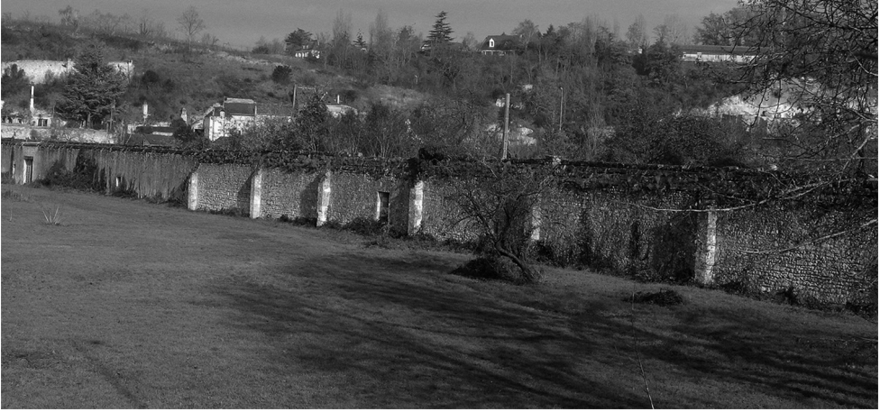
Fig. 14. L'abbaye de Marmoutier (Tours) : vestiges de la muraille d'enceinte.
