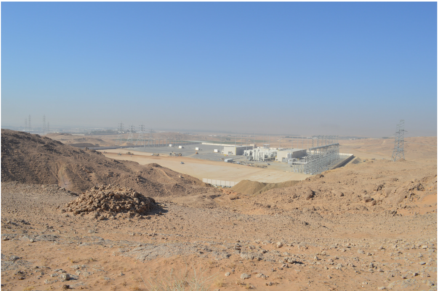
Figure 14 : Jibāl Umm al-Rūs – Centrale électrique aux abords immédiats de la nécropole JUR1 (A. Chevalier – Mission archéologique franco-saoudienne dans l'oasis d'al-Kharj).
