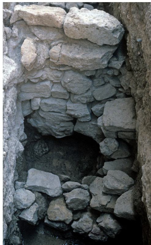
■ 19 Empilement de murs formant le mur MR1027. Au premier plan le mur primitif MR1116. Vue de l'est (photo : J. Chausserie-Laprée).
