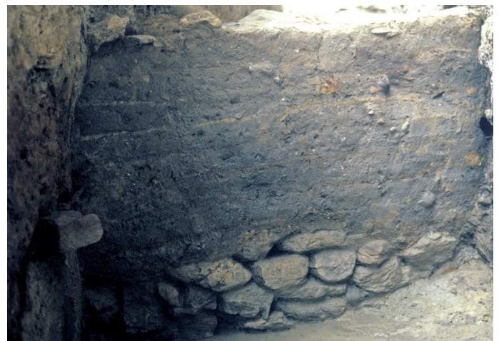
■ 12 Mur MR1061 avec son élévation en briques crues et les joints sont encore visibles. Vue de l'ouest (photo : J. Chausserie-Laprée).
