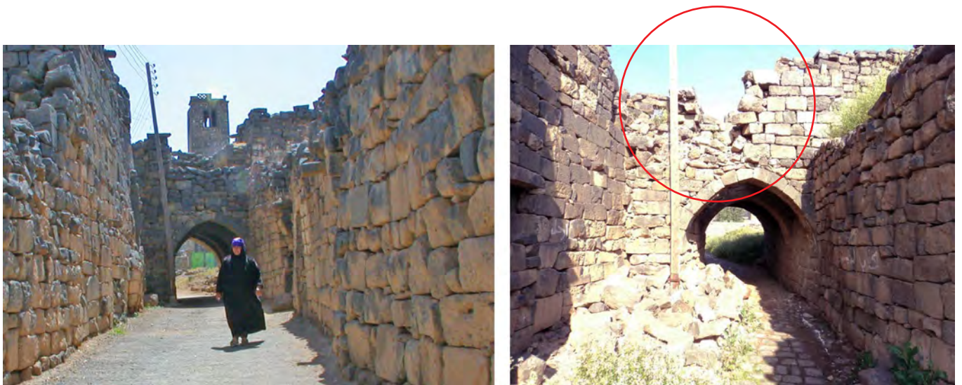
Fig. 44 : Ruelle entre la mosquée d'Omar et la mosquée de Fâtima, façade ouest du passage voûté, état en 2003 (à gauche) et actuel (à droite)
