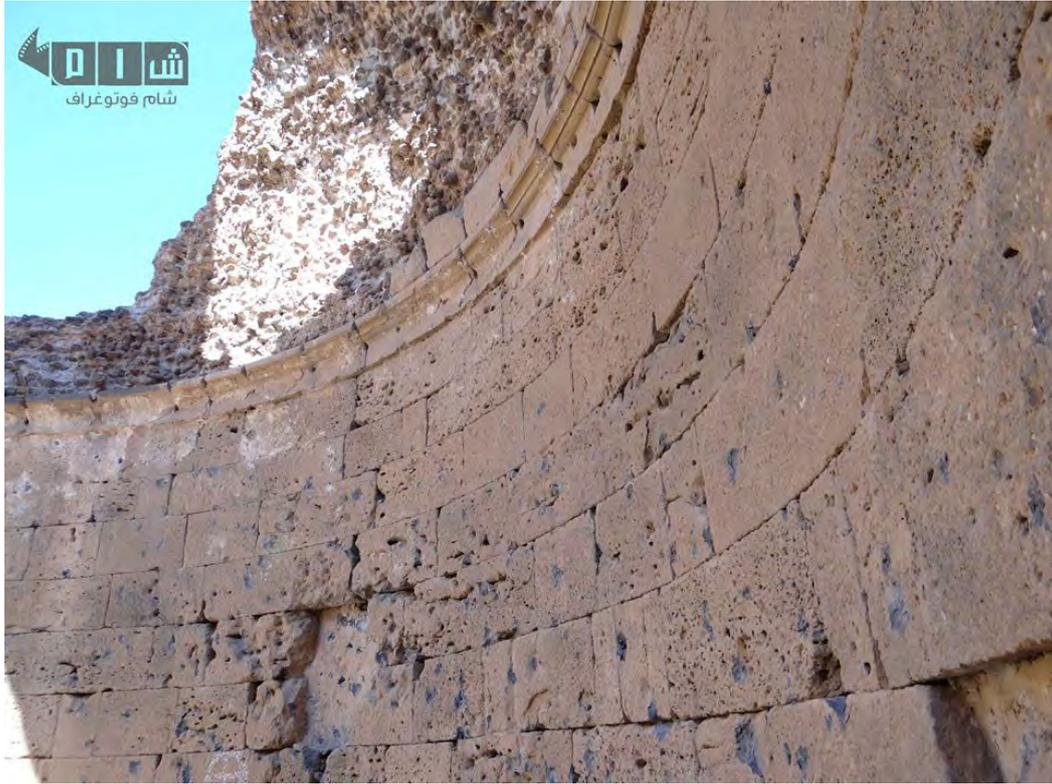
Fig. 59 : Basilique de Bahîra, détail de l'élévation intérieure est (abside), traces d'impacts (cliché «Sham», 2012).
