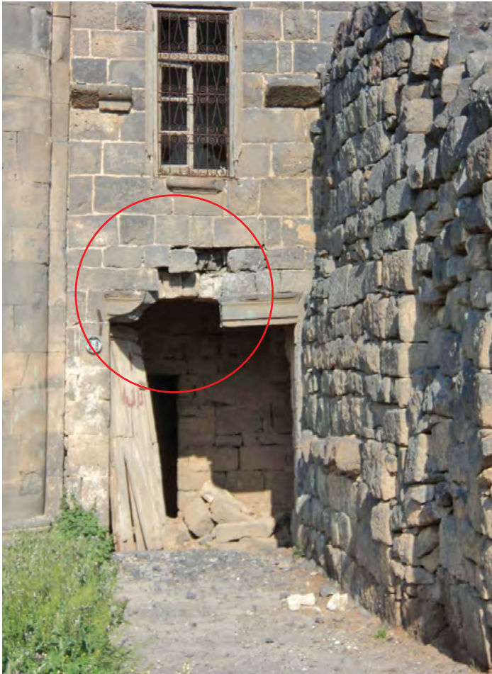
Fig. 61 : Basilique de Bahîra, détail de l'élévation extérieure ouest, porte à l'est de la façade (avril 2015).
