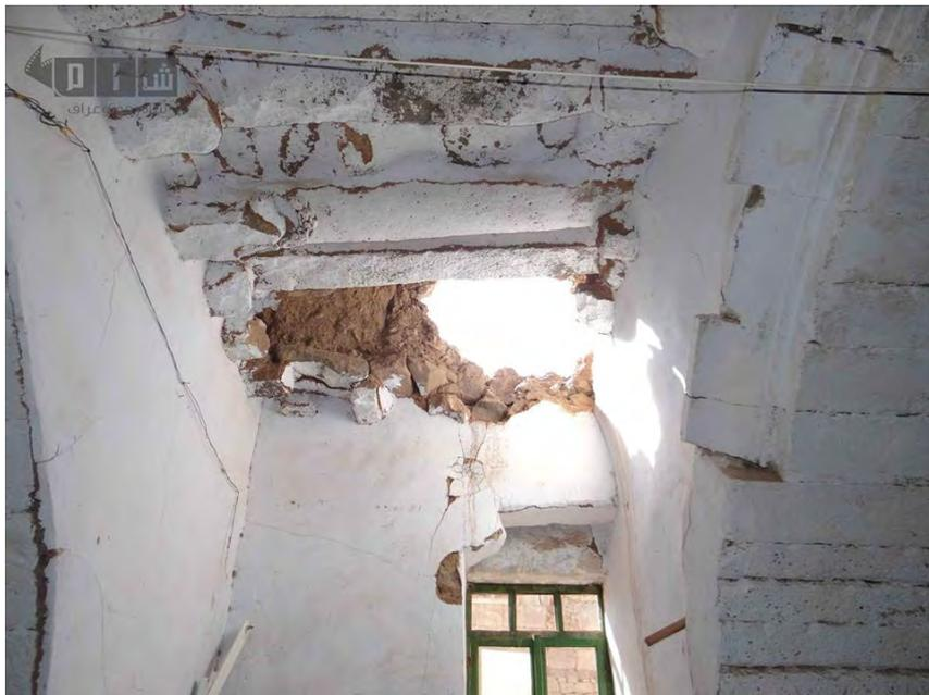
Fig. 13 : Mosquée de Fâtima, lacune dans la couverture de la salle de prière
