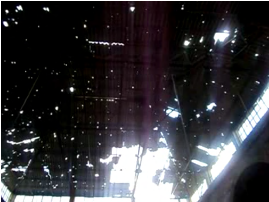
Fig. 52 : Mosquée d'Omar, vue intérieure de la couverture de la salle de prière (cliché extrait d'une vidéo du 12 avril 2015)
