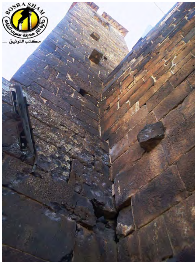
Fig. 48 : Mosquée d'Omar, jonction façade nord / minaret
