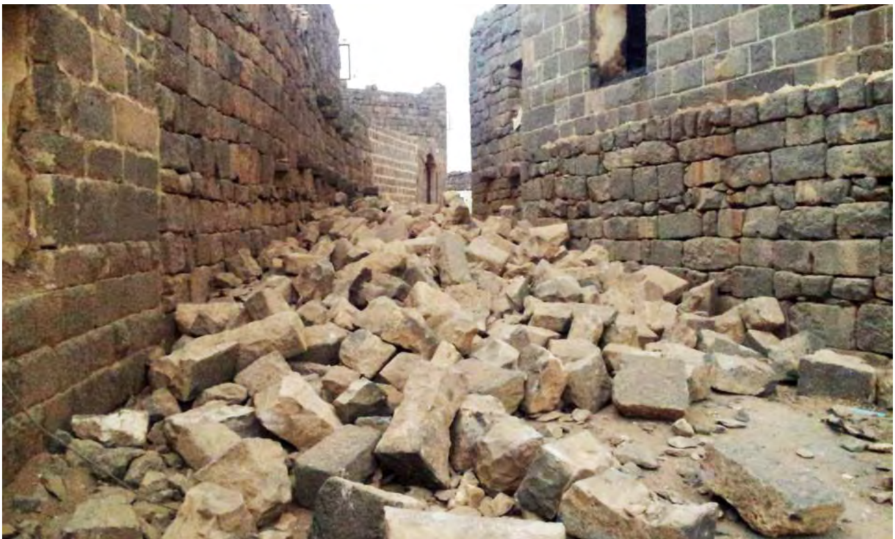
Fig. 64 : Ruelle à l'est de la maison du Sheikh, vers le nord (état en 2013).
