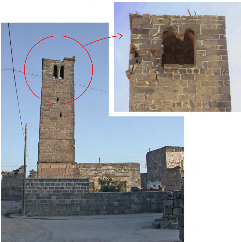
Fig. 11 : Minaret de la mosquée de Fâtima. État en 2003, façade ouest (à gauche) et état actuel de la façade nord (en haut à droite)
