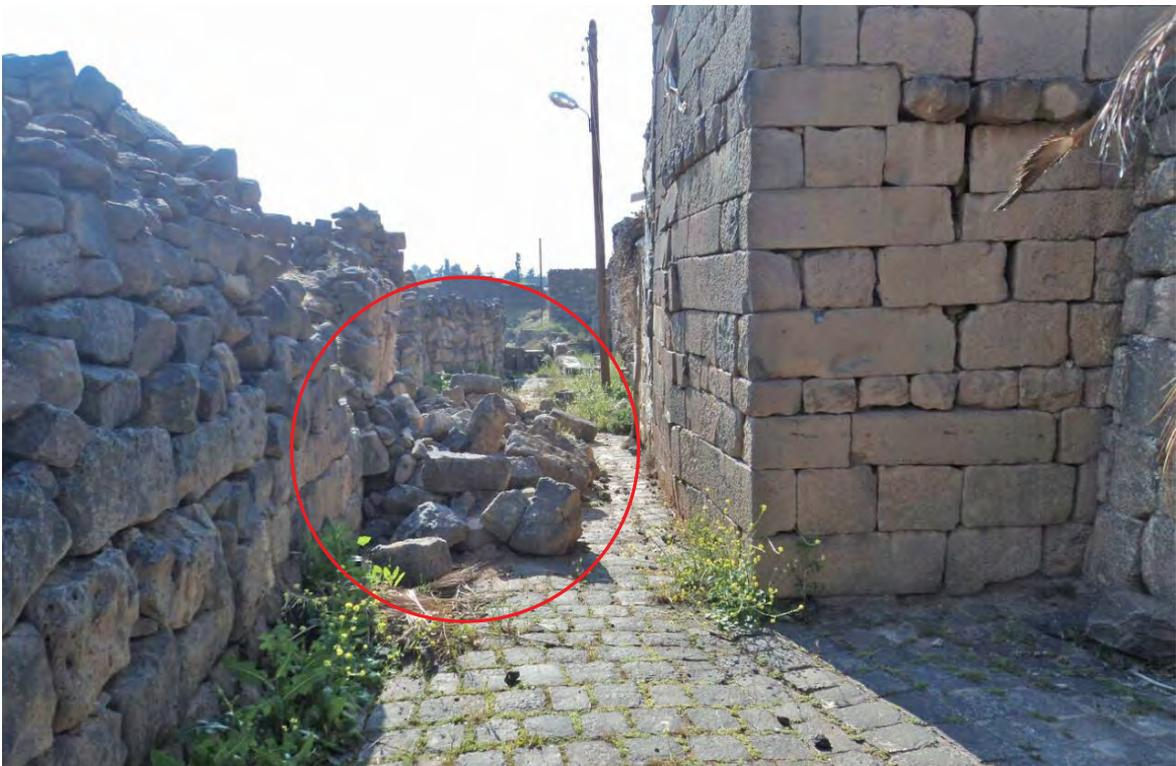
Fig. 46 : Ruelle entre la mosée d'Omar et la mosquée de Fâtima, éboulement d'une partie de la façade sud.
