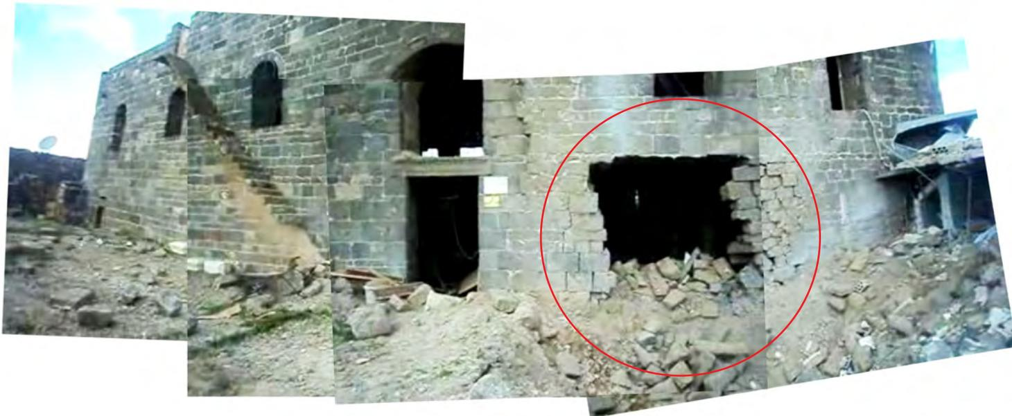
Fig. 49 : Mosquée d'Omar, façade ouest éventrée par l'explosion d'un baril de TNT
