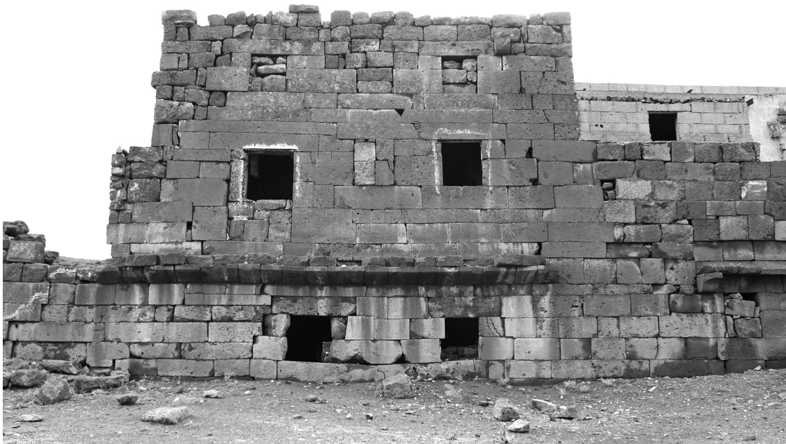
Figure 10. Bosra. Façade ouest sur rue de la maison 2 © P. Piraud-Fournet, 2010.
