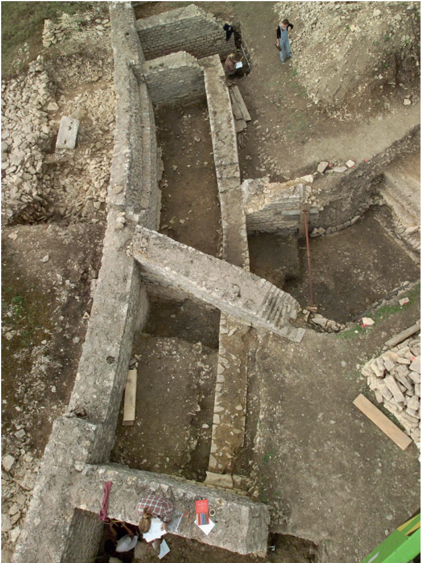
2. Accès nord du théâtre. Cage d'escalier modifiée par l'adjonction de contreforts (2004). Cliché Archeodunum.
