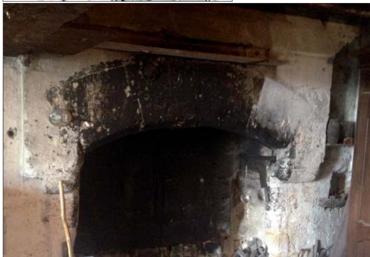
Cheminée du 13 e ou 14 e siècle, avec ses claveaux à crossettes
