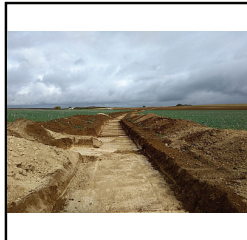
Photo 42 Vue générale de la tranchée 7 - (Gaultier Matthieu)
