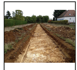
Photo 45 Vue générale de la tranchée 16 - (Gaultier Matthieu)
