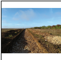
Photo 46 Vue générale de la tranchée 10 - (Gaultier Matthieu)
