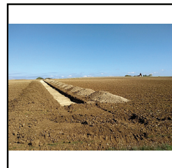
Photo 44 Vue générale de la tranchée 11 - (Gaultier Matthieu)
