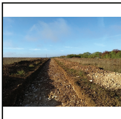
Photo 46 Vue générale de la tranchée 10 - (Gaultier Matthieu)
