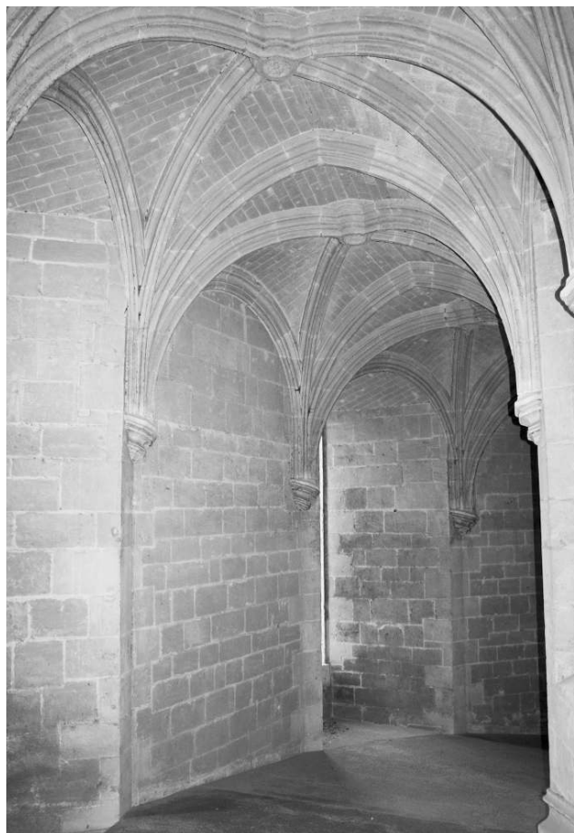
Figure 3 : (Voir planche couleur V) Vue de la rampe cavalière de la tour des Minimes du château d'Amboise (© L. Gaugain). Figure 3: (See colour plate V) View of the ramp in the Tour des Minimes of the Amboise castle (© L. Gaugain).
