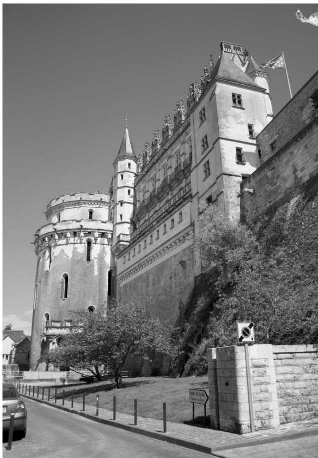
Figure 2 : Vue de la tour des Minimes du château d'Amboise depuis la rue de la Concorde (© L. Gaugain). Figure 2: View of the Tours des Minimes in the Amboise castle from rue de la Concorde (© L. Gaugain).
