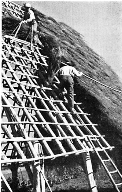
Fig. 60 Fixation des bottes en rangées verticales (STEMMERMANN 1942).
