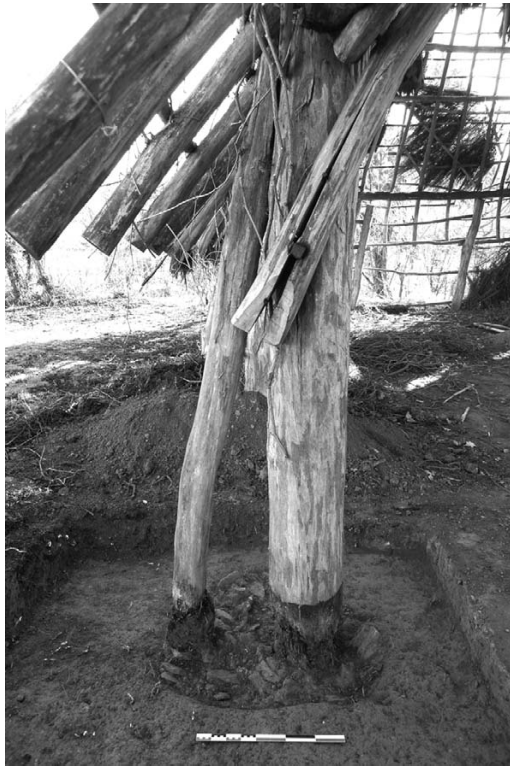
Fig. 51 Vihiers, « La Dauphinerie ». Deuxième poteau du pan est, avec sa contrefiche (cl. F. É.).
