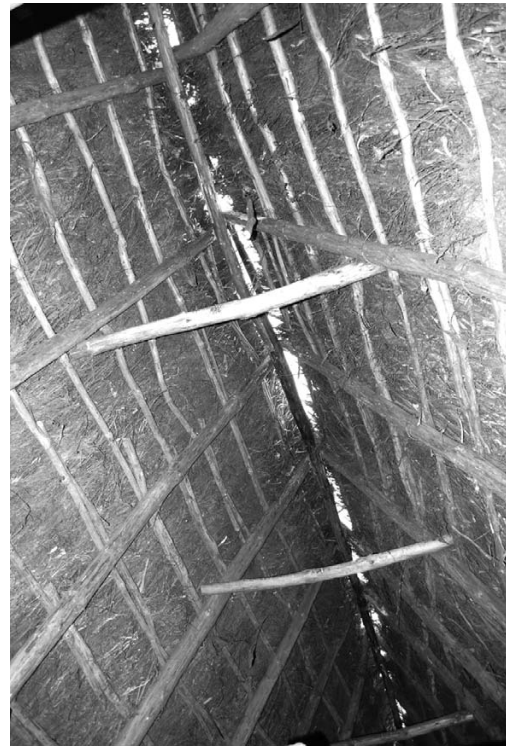
Fig. 11 Ambillou, «La Chaussée». Partie haute de la charpente (cl. F. É.).
