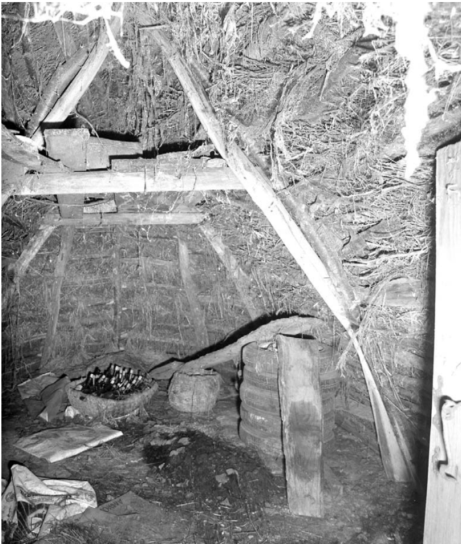
Fig. 5 Vue intérieure avec les arbalétriers courbes plantés en terre. Le Cambout, « Gastry », Côtes-d'Armor, 1995 (cl. Artur et Lambart, Serv. rég. Inv. Bretagne).
