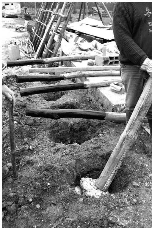
Fig. 13 Saint-Laurent-du-Lin, «La croix du Chêne pilé». Calage des chevrons sur une pierre plate au fond des trous (cl. F. É.).
