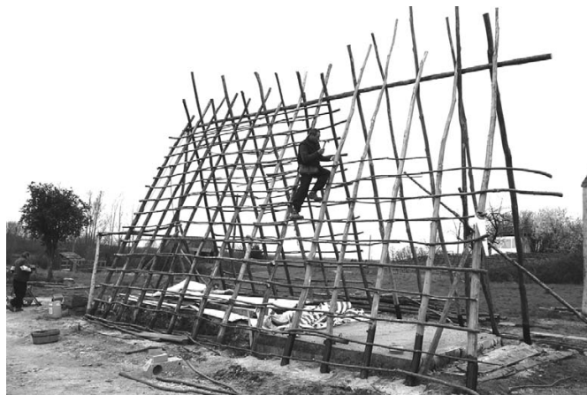
Fig. 14 Saint-Laurent-du-Lin, «La croix du Chêne pilé». Cloutage du lattis en perches de châtaignier (cl. F. É.).
