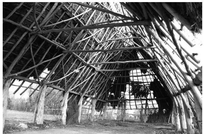
Fig. 43 Vihiers, « La Dauphinerie ». Charpente à fermes et pannes (cl. F. É.).
