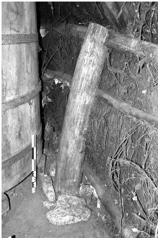
Fig. 28 Ambillou, « La Giberdière ». Poteau planté, avec pierres de calage en pied, déversé sous la poussée des fermes (cl. F. É.).
