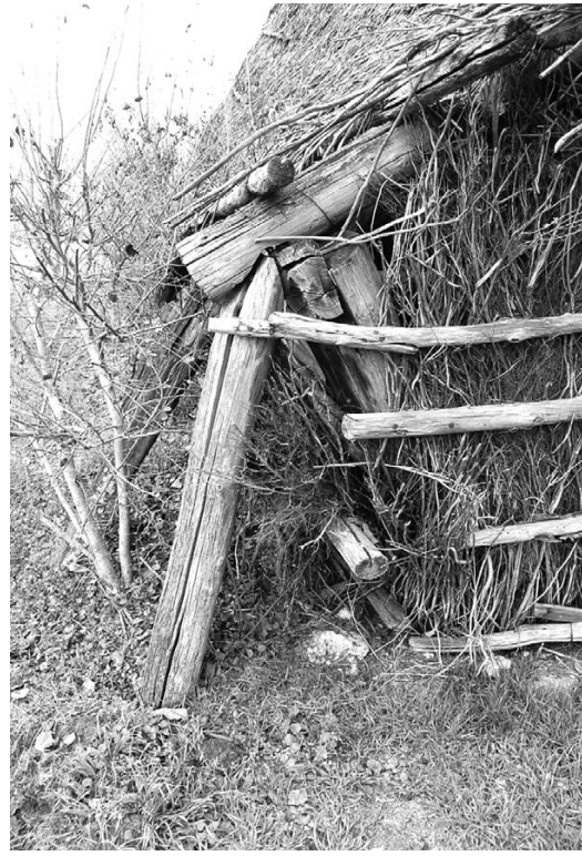
Fig. 32 Ambillou, « La Giberdière ». Poteau oblique de soutien (cl. F. É.).
