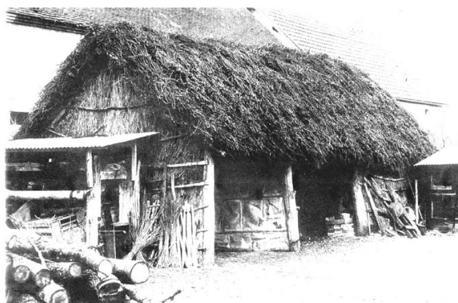
Fig. 3 Remise agricole à poteaux plantés, Nièvre, début XX e siècle (GUIBAL 1982, p. 35).
