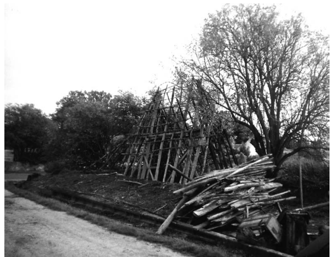
Fig. 37 Notre-Dame d'Alençon, « La Mare ». Loge en cours de démontage, 2006 (cl. Rocher J.).
