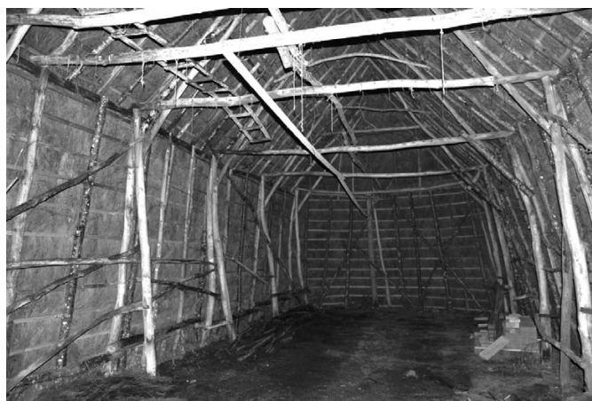
Fig. 40 Cléré-les-Pins, « Le Boulay », charpente constituée de perches (cl. F. É.).
