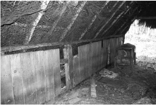
Fig. 20 Ambillou, « La Girardière ». Cloison interne fixée aux poteaux plantés (cl. F. É.).
