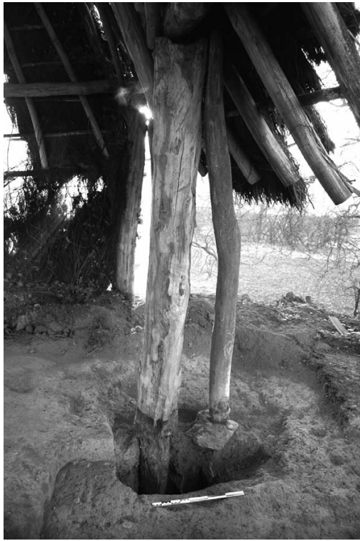
Fig. 48 Vihiers, « La Dauphinerie ». Cinquième poteau ouest avec son poteau oblique appuyé sur une pierre (cl. F. É.).
