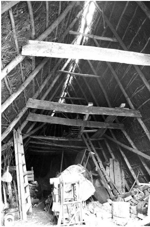
Fig 10 Ambillou, «La Chaussée». Vue intérieure (cl. F. É.).
