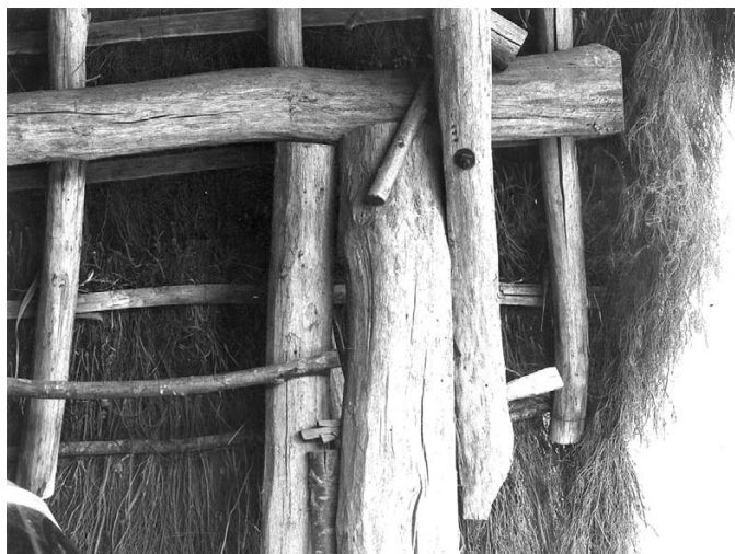
Fig. 65 Gennes, « Le Haut Davy », 1982. Fixation des arbalétriers aux poteaux par chevillage et aux sablières par un boulon (B. Rousseau, Inventaire du Patrimoine, Conseil général de Maine-et-Loire ).
