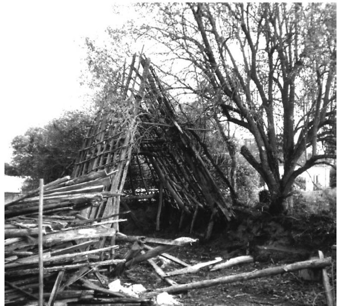
Fig. 36 Notre-Dame d'Alençon, « La Mare ». Loge en cours de démontage, 2006 (cl. Rocher J.).
