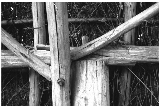
Fig. 46 Vihiers, «La Dauphinerie». Enture biaise des sablières, chevillée en tête d'un poteau (cl. F. É.).
