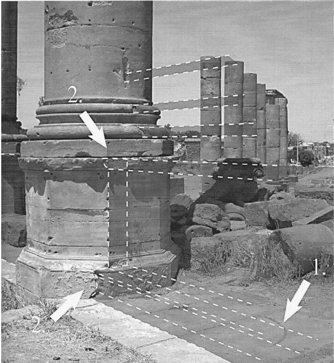
FIG. 8. FAÇADE DE L'EXÈDRE, RESTITUTION D'UN MUR BAHUT ENTRE LES COLONNES (TH. FOURNET).
