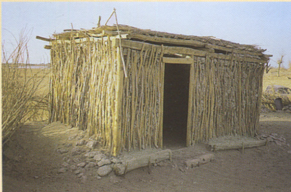
Fig. 3. La mosquée de Kumalawat, 1997 (photo A. Cornet).
