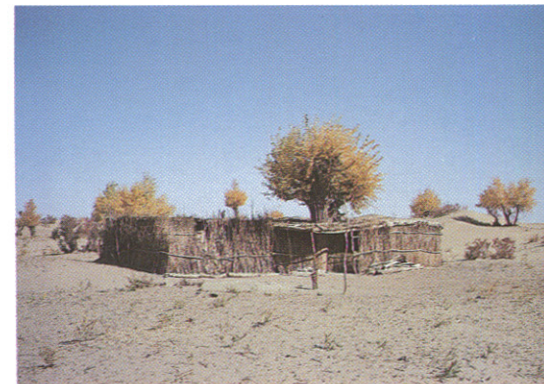
Fig. 5. Maison à Yegen, 1991. Le peuplier est intégré dans l'architecture (photo MAFCX).
