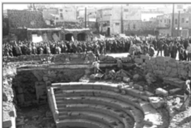
Fig. 17 - Suweida : Travaux de restaurations de l'Odéon.
