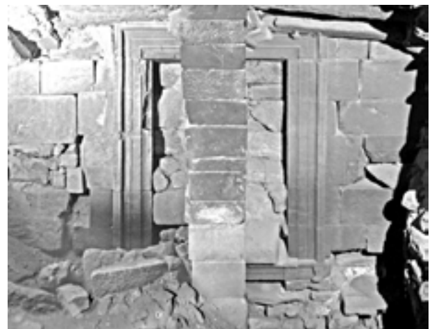
Fig. 6 - Bosra : porte latérale nord de l'Arc, actuellement en sous-sol (montage de photographies restituant une vue frontale par Thibaud Fournet).
