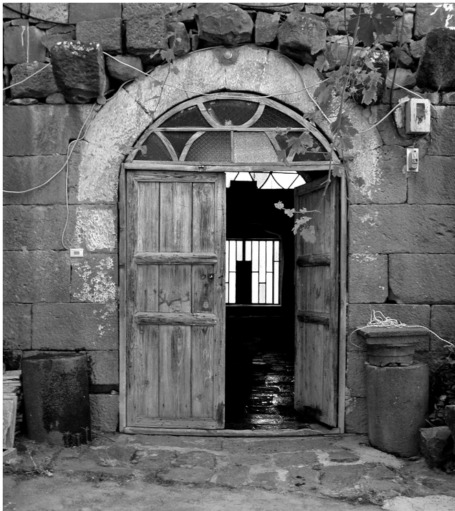
Fig. 18 - Vue extérieure du caldarium (façade nord), emplacement supposé de la chaudière sous l'arc de la porte actuelle et départ de la saignée (en bas à gauche) pour la canalisation d'adduction du labrum.
