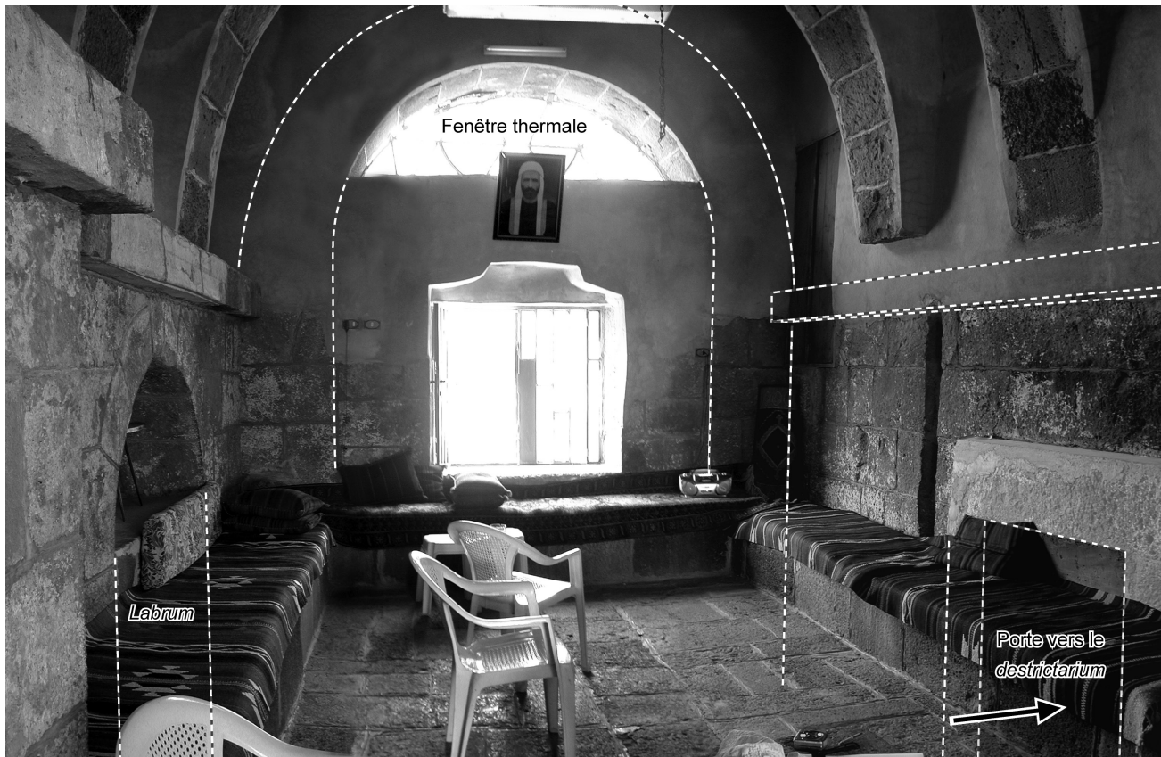
Fig. 17 - Le caldarium, vue d'ensemble vers le sud, localisation de la porte en provenance du destrictarium/laconicum.
