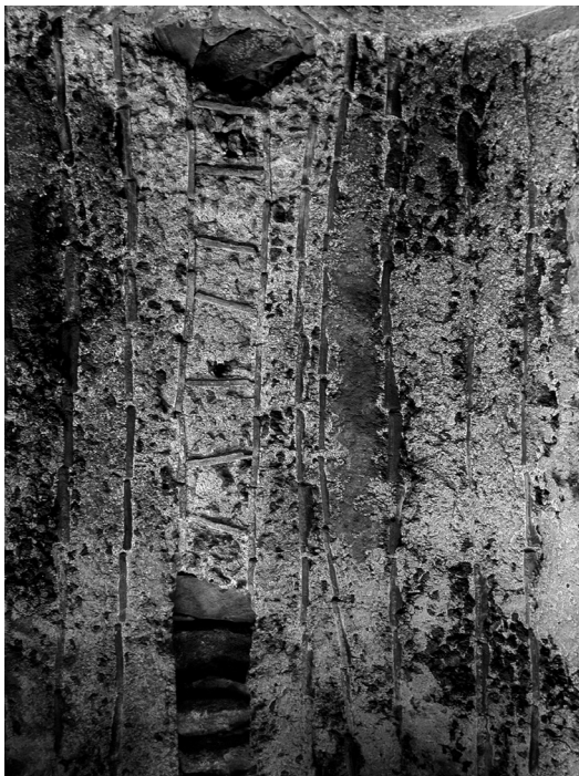
Fig. 12 - Intrados de la voûte du frigidarium (vue zénithale, le nord est ici en haut), disposition de l'opus caementicium entre des rangs ou des caissons de briques posées de champ.
