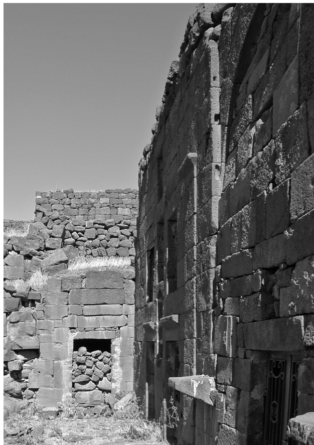
Fig. 15 - Façade sud des bains, vers l'ouest. Détail sur les dispositifs de fermeture des fenêtres.
