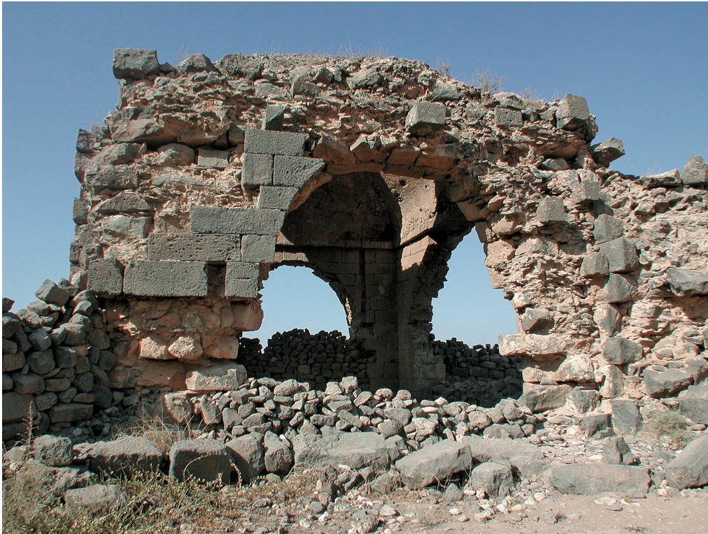
Fig. 13 – Bosra, bains du camp romain. Vestiges de la salle chaude orientale, vers l'ouest.
