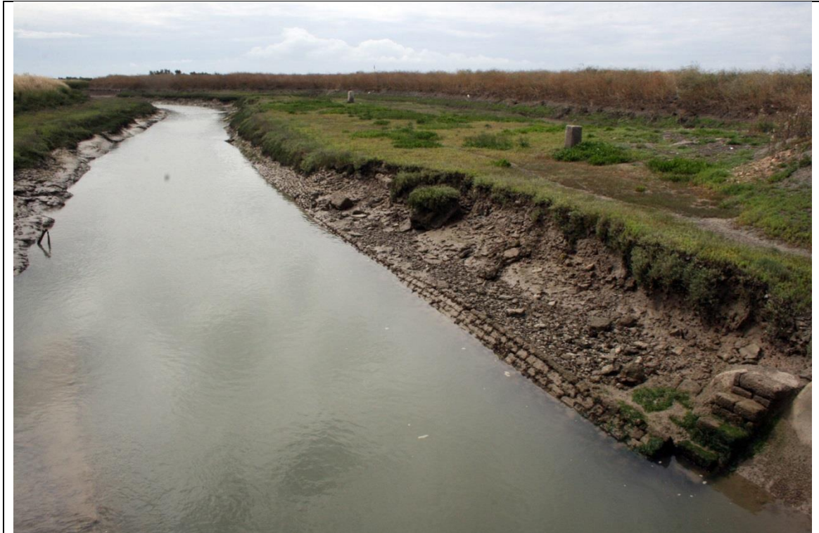
Fig. 15 : Empierrement et escalier en bord de chenal permettant le chargement/déchargement du sel (B. Gissingier).
