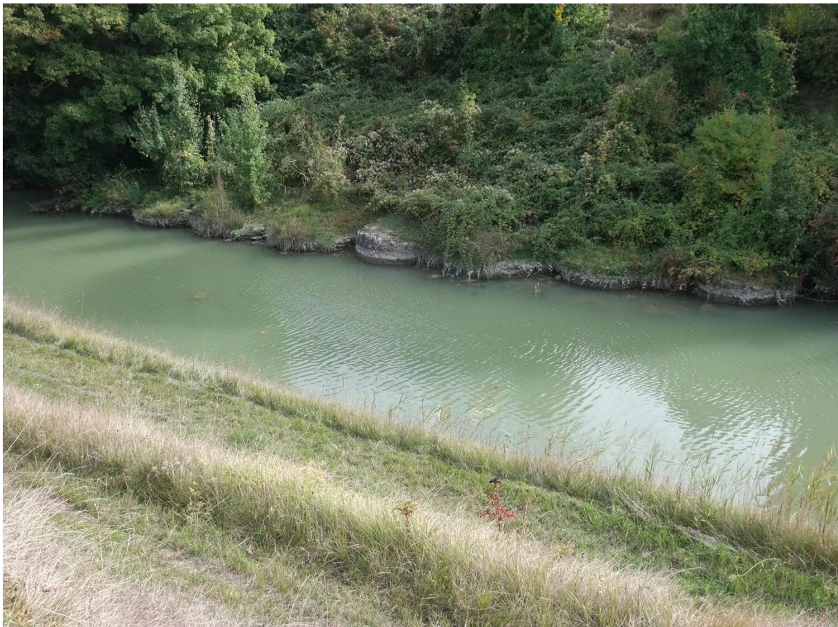
Figure 10 : Bases du quai inachevé. Port fluvial de Saint-Agnant. Fin 18e siècle.
