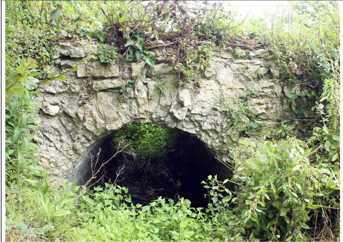
Fig. 14 : petit pont de pierres voûté en plein-cintre (B. Gissinger).
