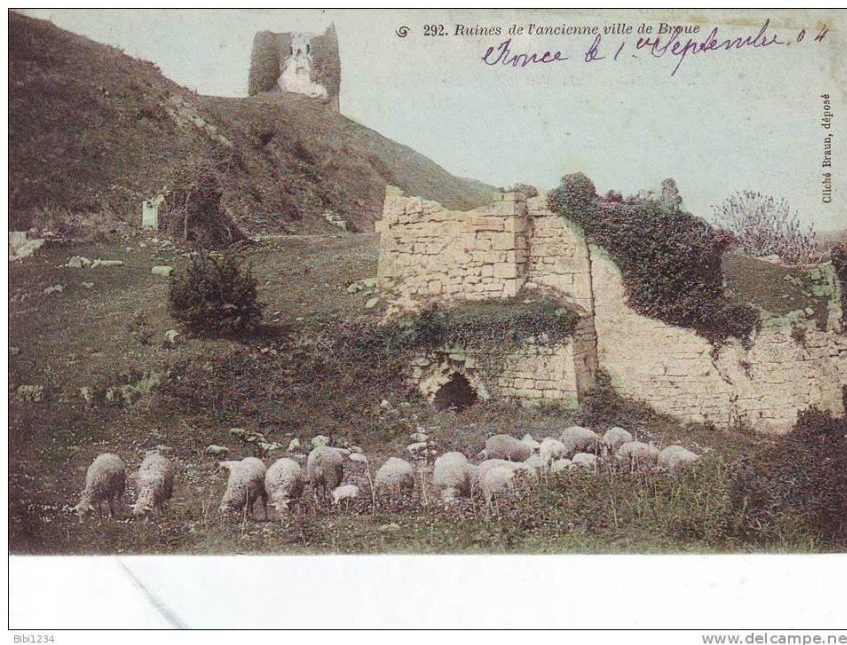
Fig. 24 : vue des ruines de la tour de Broue et d'un four de tuilier au début du XX e siècle.
