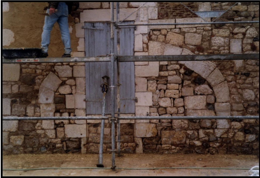
Fig. 7 : Ci-dessus photographie « ancienne » (années 1990) de la façade de l'édifice ci-dessus, en cours de rejointoyage. On voit nettement l'utilisation de pierres de lest dans les maçonneries, ce qui transparait moins nettement après crépissage.
