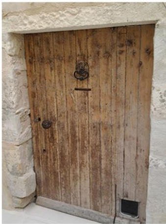
Porte cour intérieur.jpg
