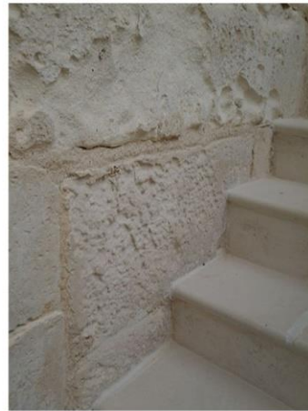
Détail pierres cour intérieur.jpg
