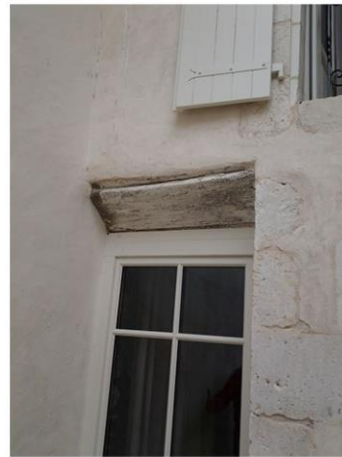
détail fenêtre cour intérieur.jpg
