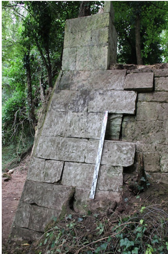
Photo 3 : Angle de la structure face ouest (E. Normand)
