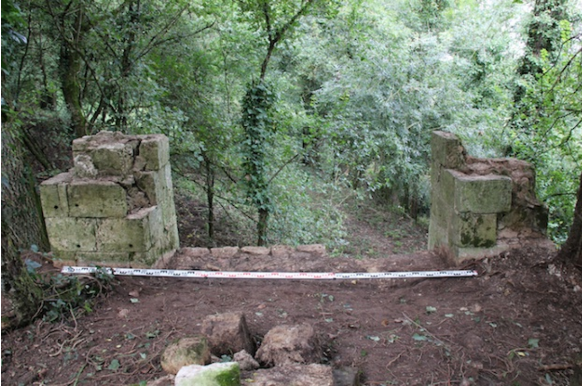
Photo 5 : Surplomb de la plate-forme par rapport au marais (E. Normand)
