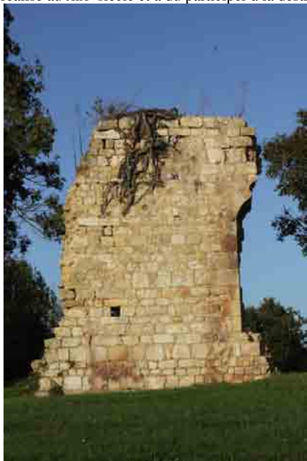
Figure 15 : Mur gouttereau de l'église paroissiale (Cl. E. Normand)
