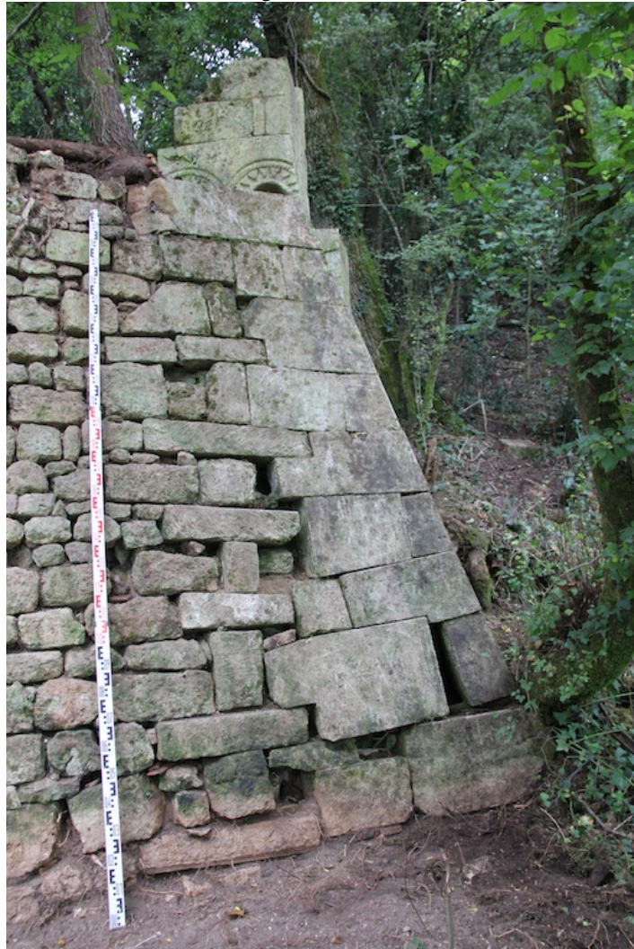
Photo 2 : Angle de la structure face ouest (E. Normand)
