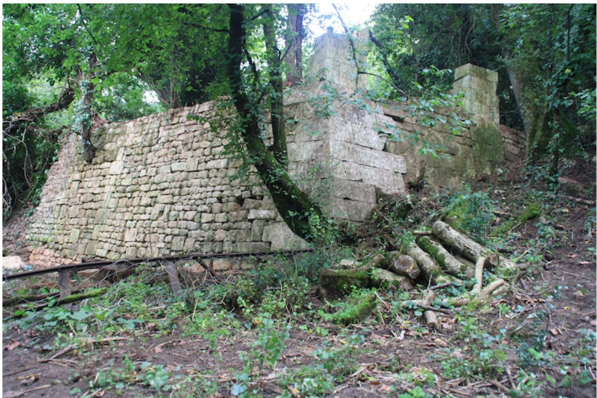
Figure 21 : Vue d'ensemble du bâtiment C (Cl. A. Champagne).
