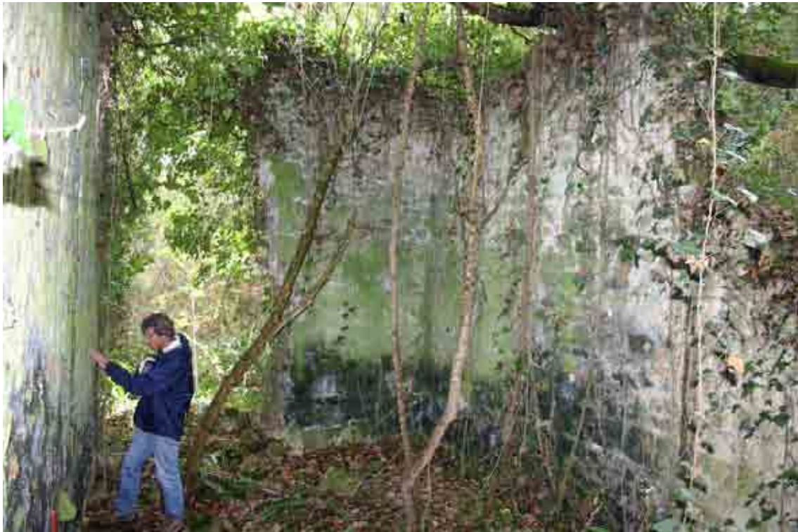
Figure 25 : Intérieur d'un des bâtiments encore en élévation (Cl. E. Normand).
