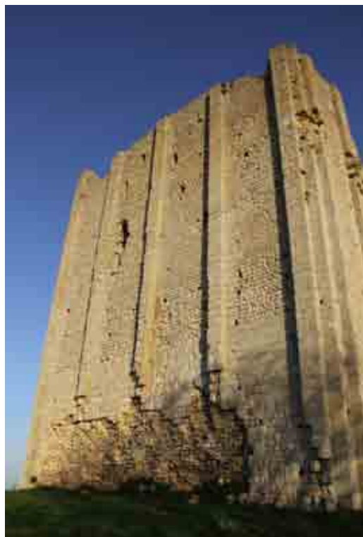
Figure 13 : façade occidentale de la tour
