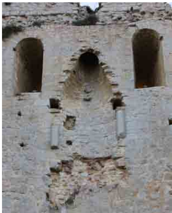
Figure 12 : Cheminée du dernier niveau (Cl. E. Normand)
