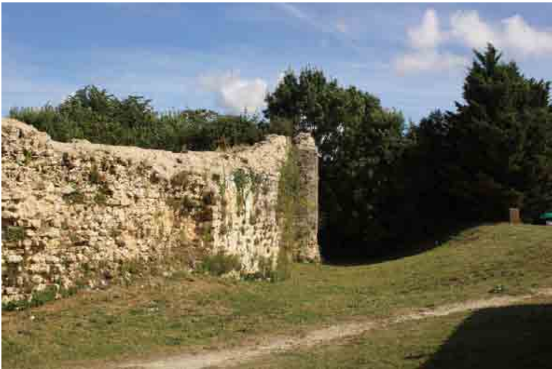
Figure 14 : Vue du fossé qui ceinture la chemise (Cl. : E. Normand).
