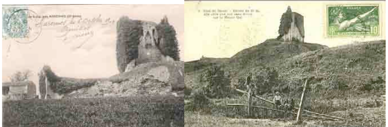
Figure 4 : cartes postales du début du xx e siècle (face sud et face nord) à remarquer l'absence de végétation à cette époque
