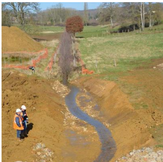
Figure 2 : un cas de réduction temporaire d'impact lors de la construction de la LGV-Bretagne Pays de Loire, la dérivation du ruisseau de la Crochardière, affluent de la Sarthe, 72 (Cliché Eiffage)
