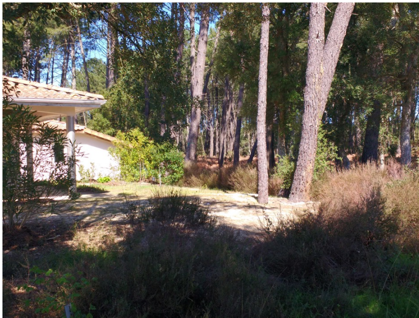
Figure 6 : Zone d'interface forêt-bâti. Débroussaillage non appliqué en lisière de forêt : commune de Messanges. Source : Auteurs. / Wildland urban interface : ignorance of individual forest clearing regulation. City of Messanges. Source: Authors.
