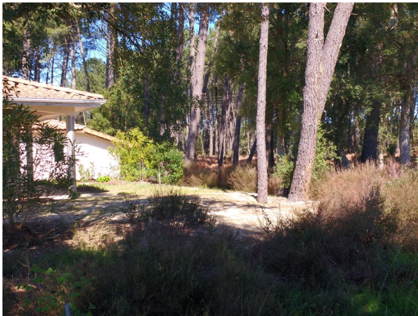
Figure 6 : Zone d'interface forêt-bâti. Débroussaillage non appliqué en lisière de forêt : commune de Messanges. Source : Auteurs. / Wildland urban interface : ignorance of individual forest clearing regulation. City of Messanges. Source: Authors.
