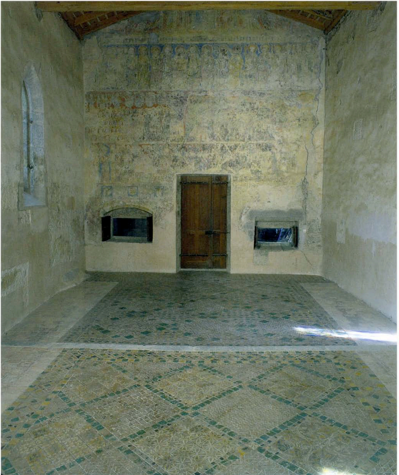
332 - Abbazia di Lagrasse, veduta dell'insieme della pavimentazione della cappella.
