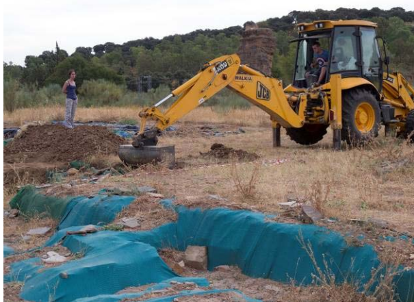
Fig. 4. Desbroce mecánico de la capa superficial.
