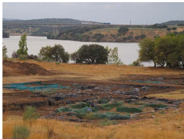
Fig. 5. Proceso de cubrición del área excavada con lona, tierra y piedras.
