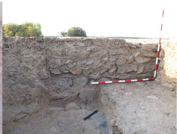
Fig. 69. Cata junto al paramento del muro M 3289 para documentar su cimentación.
