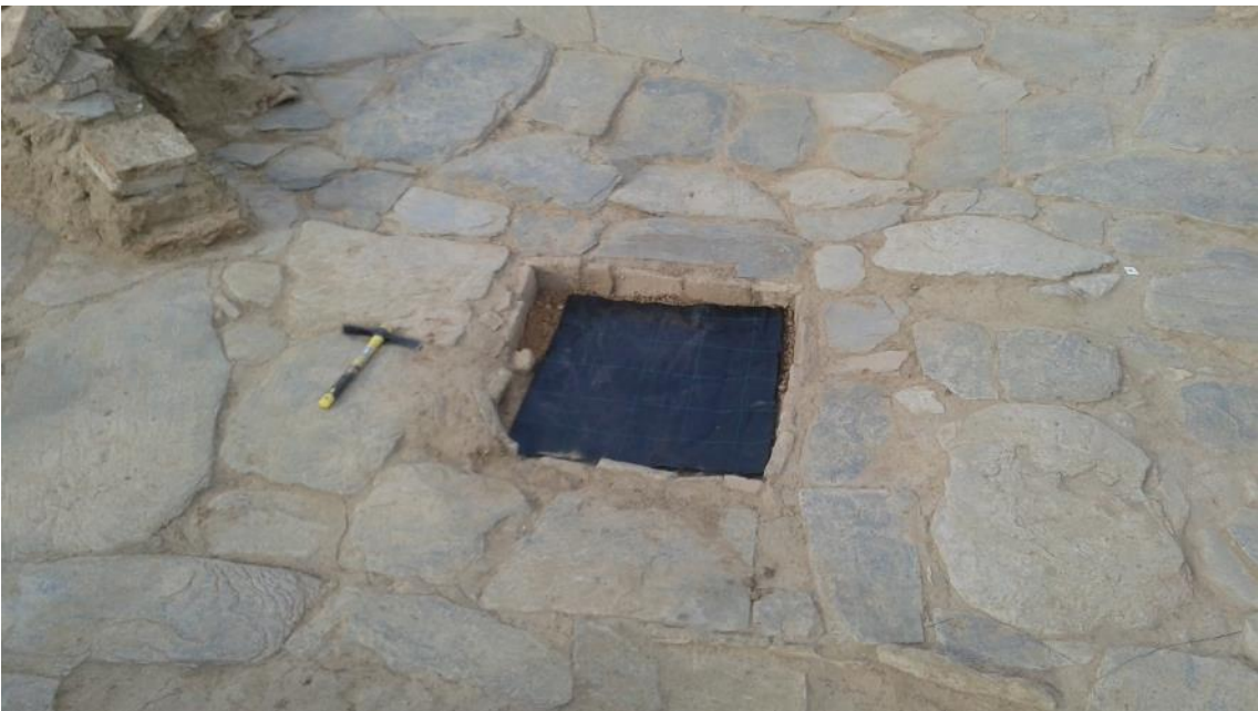
Fig. 37. Colocación del geotextil en la boca del aljibe F2993.
