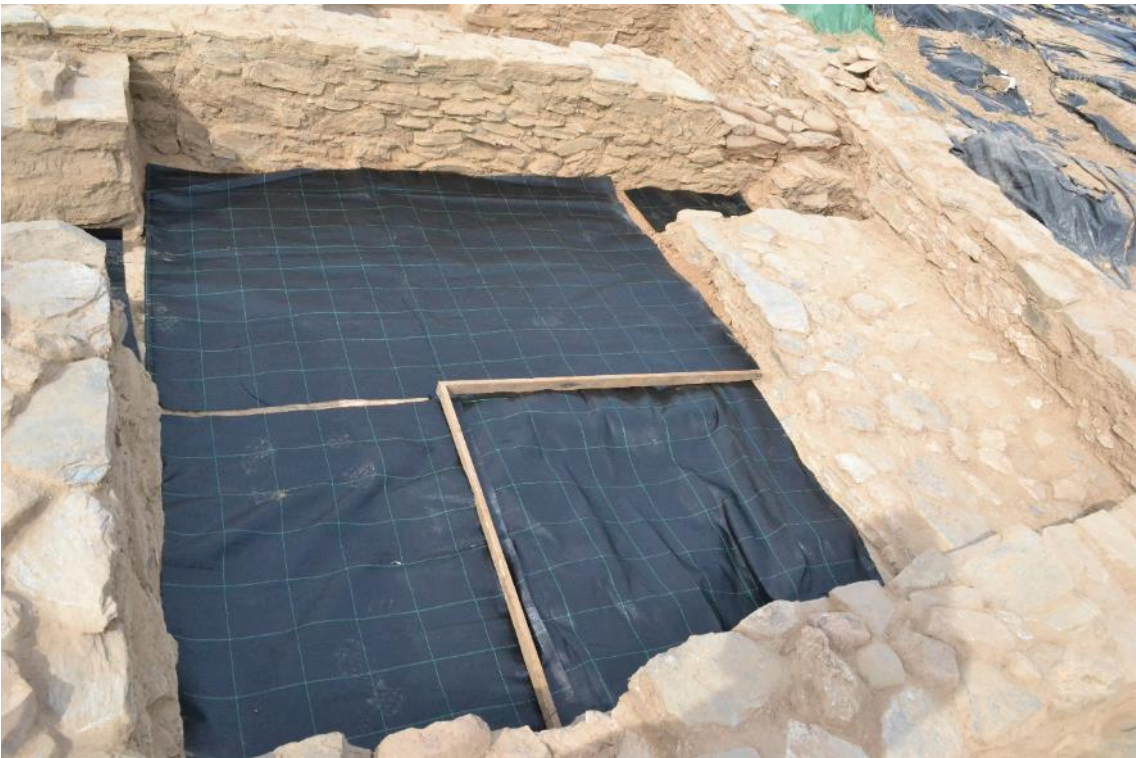
Fig. 33. Colocación de la segunda capa de geotextil, para poder rellenar posteriormente con grava de color. También se han colocado unos listones provisionales que separen los diferentes tipos de grava.
