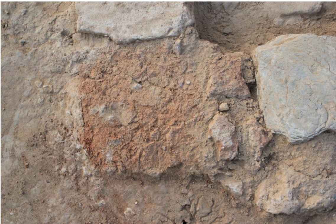
Fig. 6. Detalle de la disgregación que sufre uno de los ladrillos del hogar.
