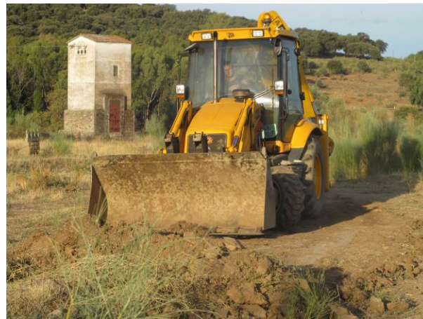
Fig. 1. Retira del nivel superficial con medios mecánicos.
