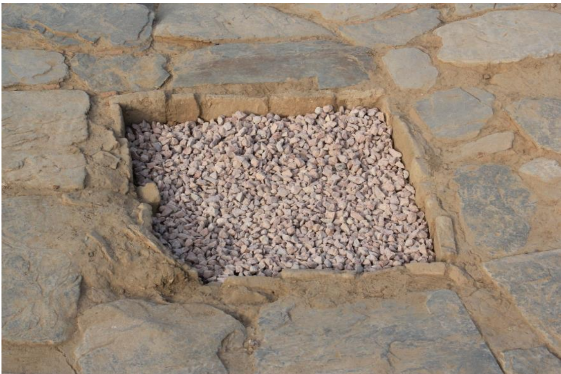
Fig. 51. Fotografía final de la boca del aljibe (estancia B).
