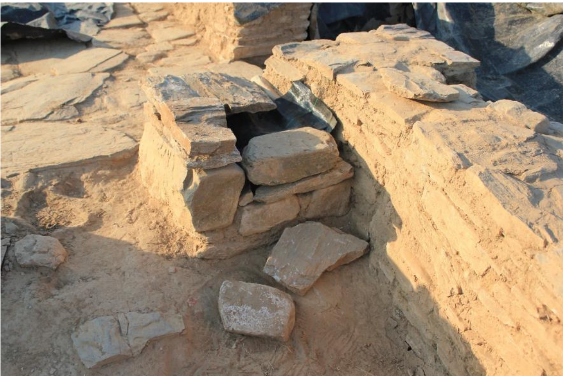
Fig. 17. Replanteo inicial de las piedras para el recrecido de la jamba M 2042.
