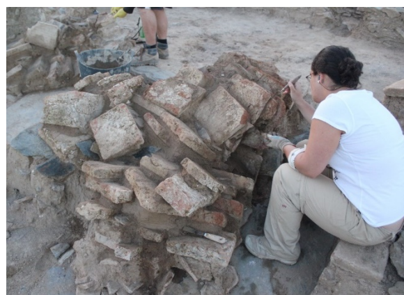
Fig. 3b. Consolidación del derrumbe de una jamba de ladrillos (© Proyecto Albalat, 2015).
