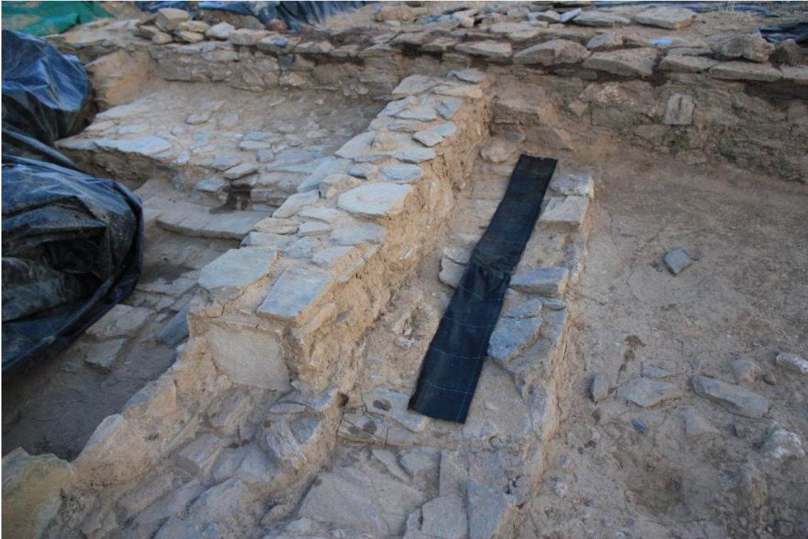
Fig. 16. Colocación de una lámina de geotextil como capa de intervención entre original y añadido, a la hora de recrear un muro.
