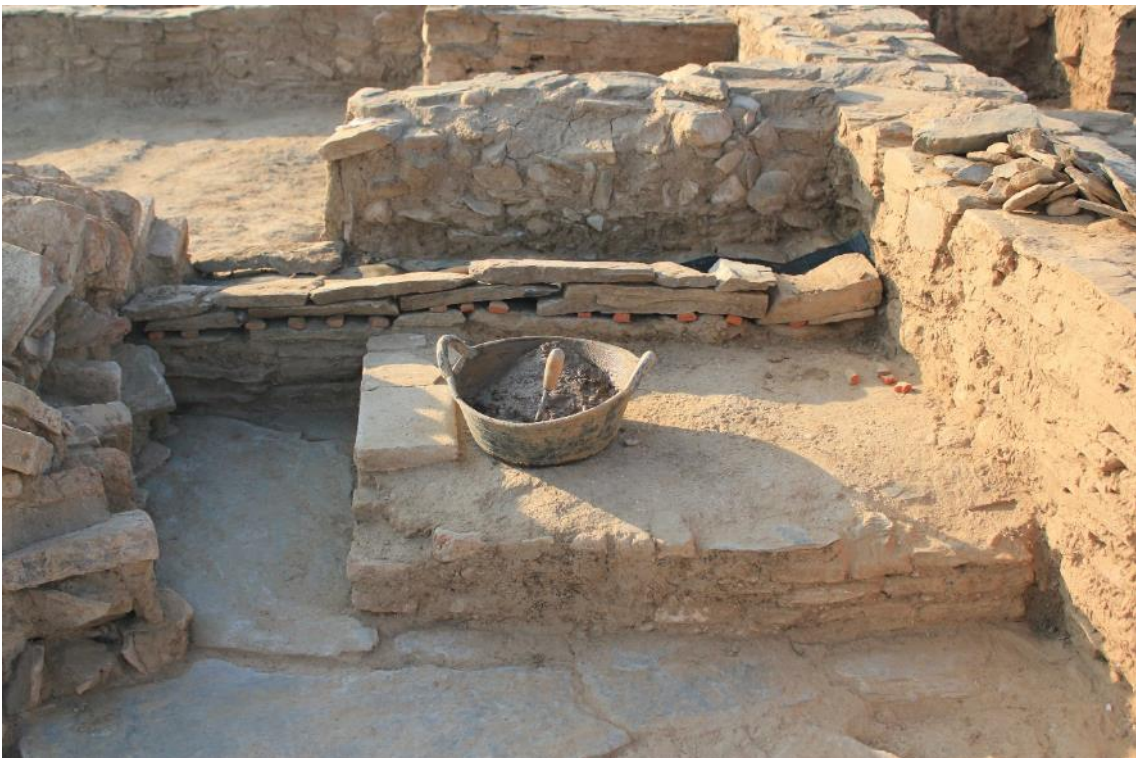
Fig. 19. Replanteo inicial de las piedras para el recrecido del muro M 2271. Pueden verse los fragmentos de teja que marcarán la separación entre original y añadido.
