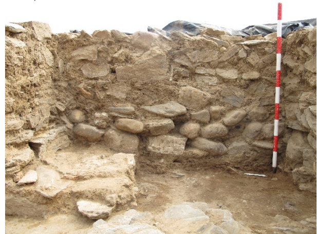
Fig. 162. Detalle del muro M5012.
