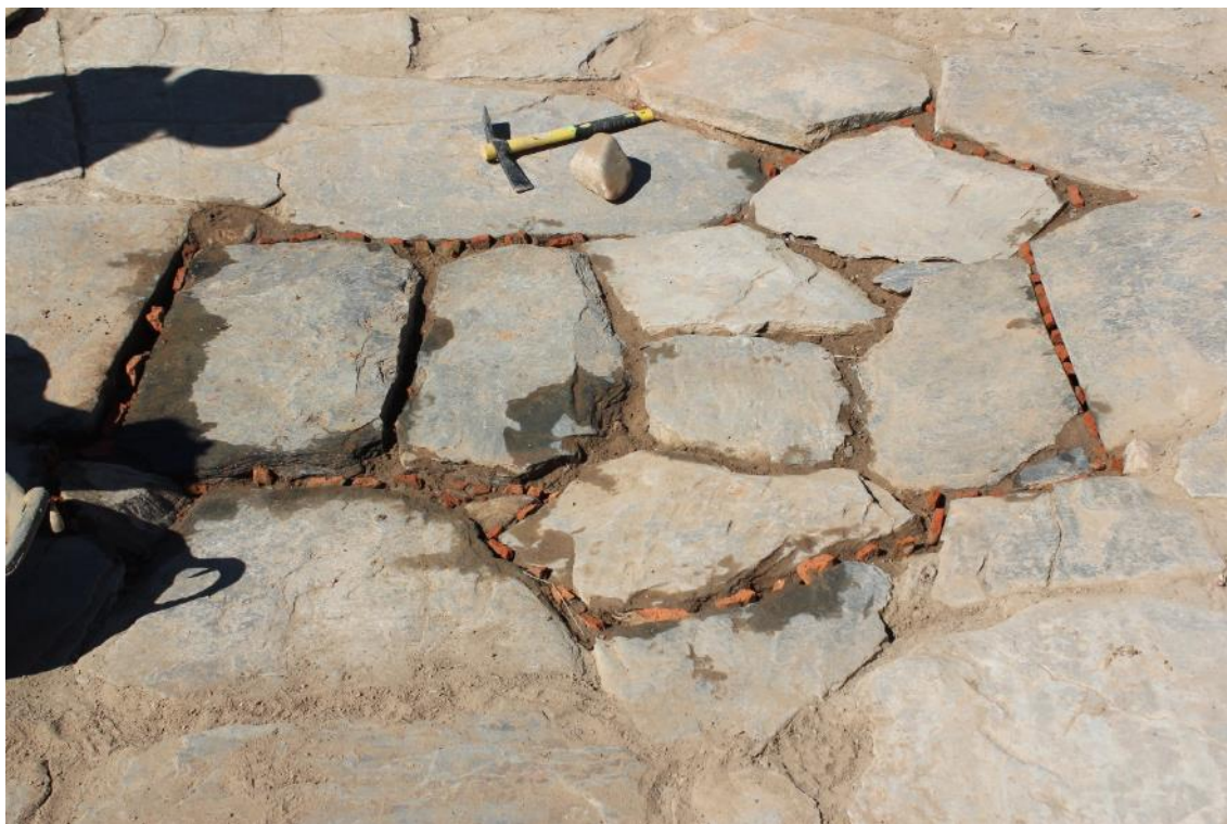
Fig. 28. Colocación de los fragmentos de teja que marcarán las zonas reintegradas.
