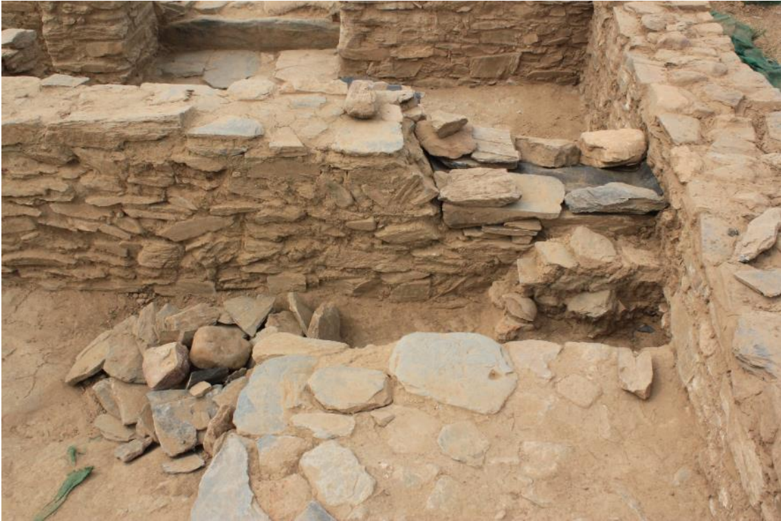
Fig. 18. Replanteo inicial de las piedras para el recrecido del muro M 2003.
