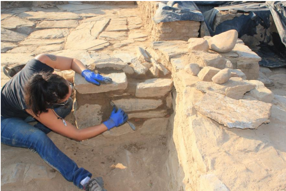
Fig. 22. Llagueado de las mamposterías tras la adhesión de las piedras.
