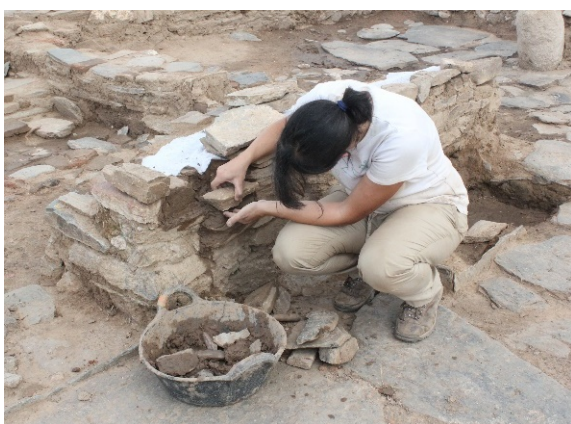
Fig. 3a. Consolidación de muros (© Proyecto Albalat, 2015).
