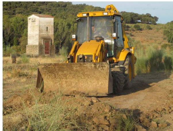
Fig. 1. Retira del nivel superficial con medios mecánicos.
