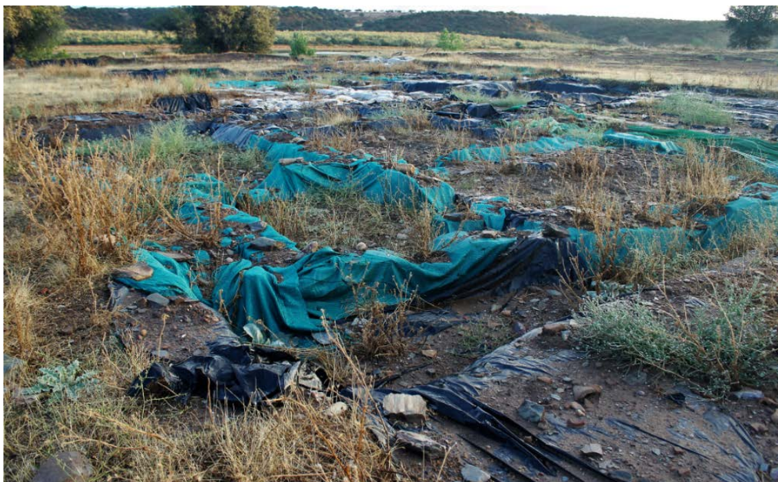
Estado de conservación del sondeo 2 previo al destapado y tratamiento.
