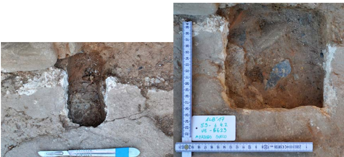
Toma de muestra y posterior ampliación para la realización de la cata.
