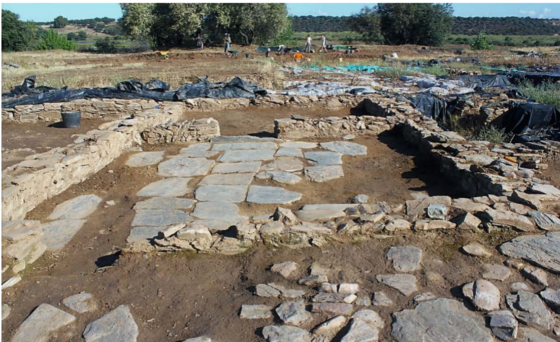
Estado de conservación del patio D y los muros que lo rodean.
