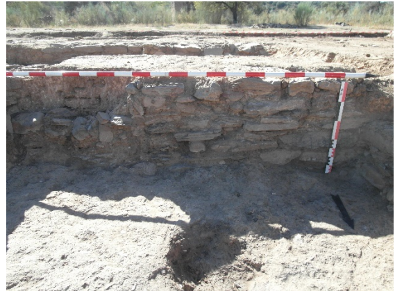
Fig. 100. Muro meridional M 6075.
