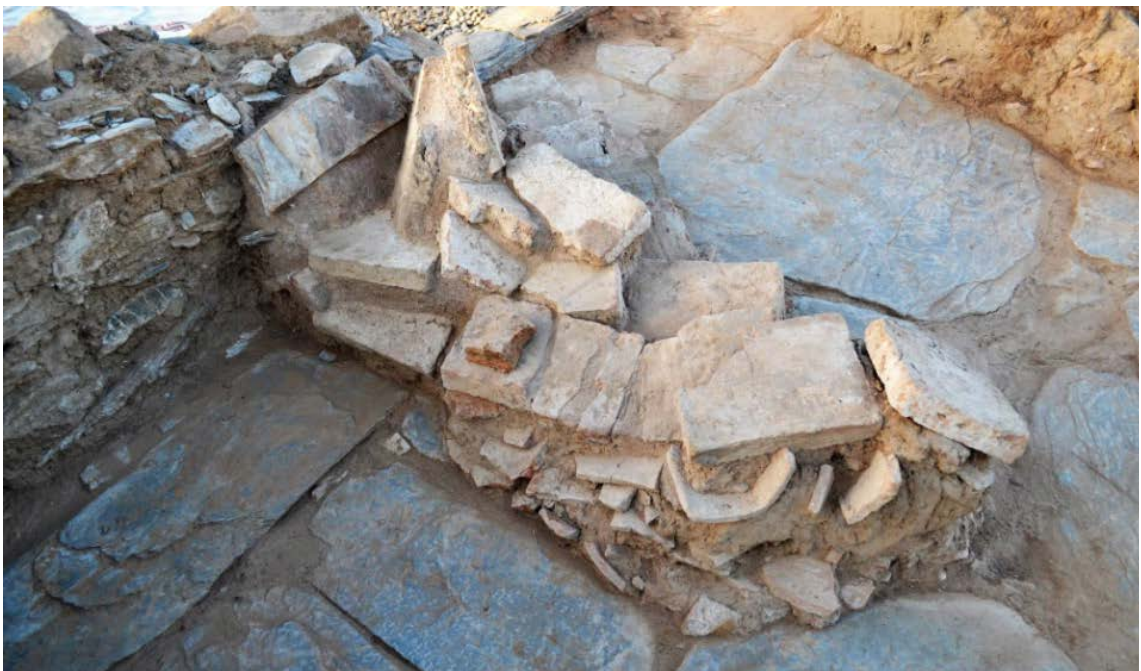
Estado de conservación de los ladrillos de la UE del arco.
