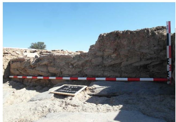
Fig. 106. Detalle del muro M 6023.
