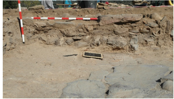
Fig. 103. Paramento del muro M 6027 que cierra al norte la estancia.
