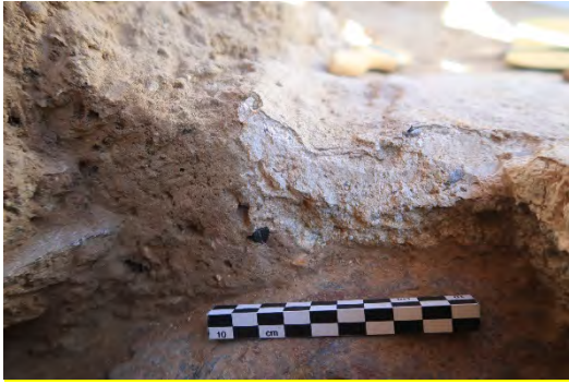
Fig. 114. Perfil norte de la cata en la cual se aprecian la superposición de dos capas de mortero (UE 5623 y UE 5626).
