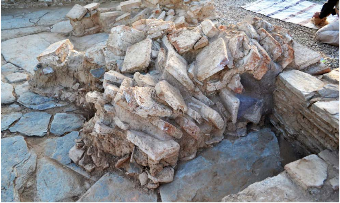
Estado de conservación de los ladrillos de la UE del arco.
