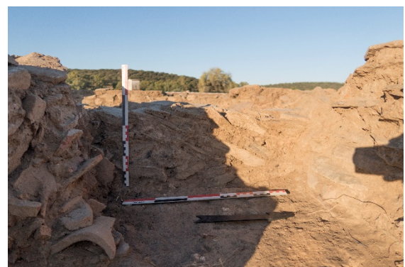
Fig. 48. Detalles de la mampostería del muro medianero entre los sectores D y C -M6023- con un aparejo en espina.
