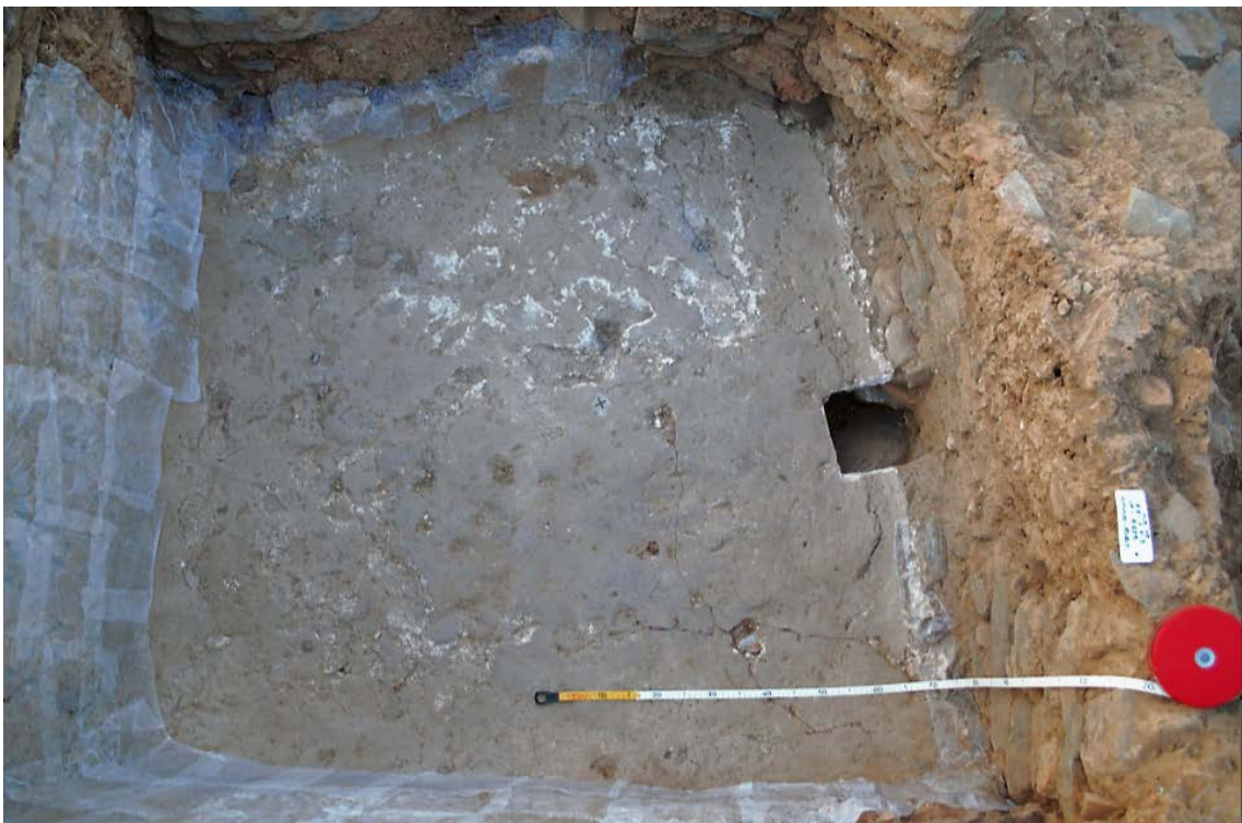
Estado final tras la consolidación del suelo y comienzo del recogido de los bordes.
