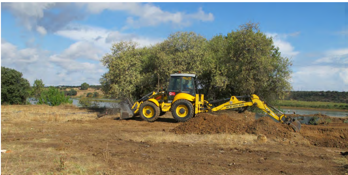
Fig. 2. Primera fase de la ampliación del sondeo 3.
