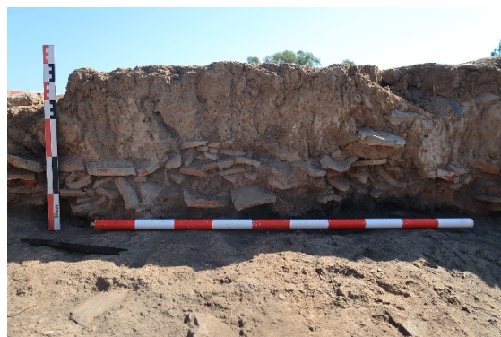
Fig. 25. Derrumbe de tejas UE 6013 documentado en el perfil este del sector (desmontado en el curso de las excavaciones).
