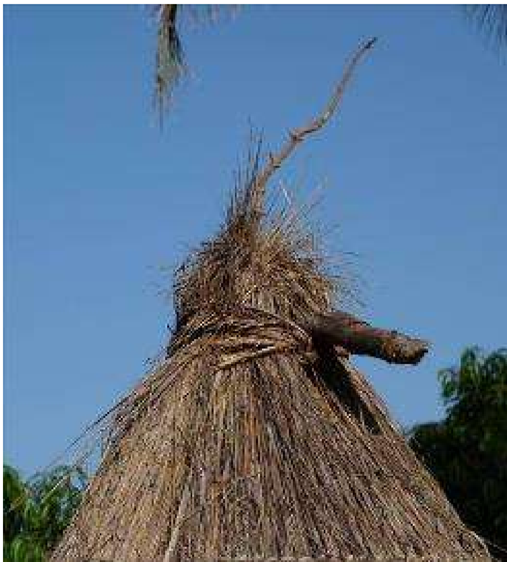
Figure 3. Petite branche de tyèèn-kaar et anneau kar sur le toit d'une maisonnette de génie (Orodara, 6 décembre 2014) ©IRD - Anne Fournier
