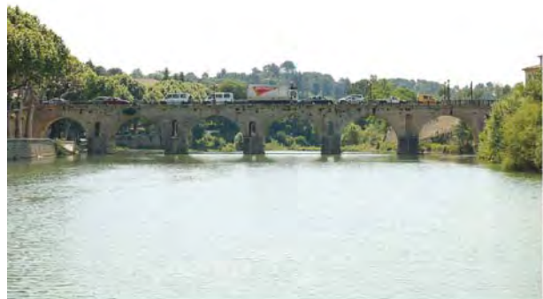
Fig. 1. Vue générale amont des sept arches traversant le Vidourle (cliché V. Mathieu - CNRS).
