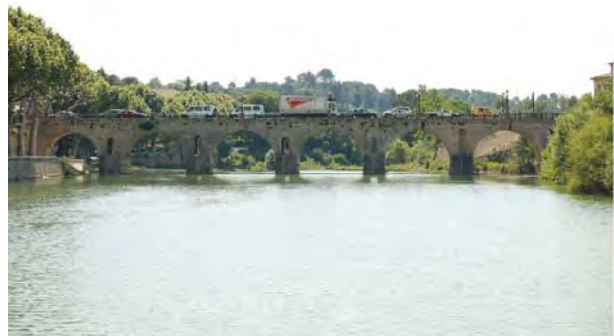
Fig. 1. Vue générale amont des sept arches traversant le Vidourle (cliché V. Mathieu - CNRS).
