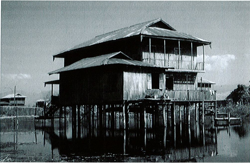
Fig. 8. Maison intha, en bois et tôle ondulée, à trois niveaux.
