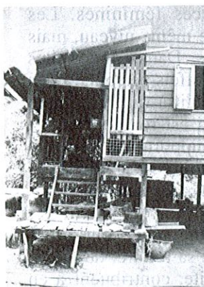
Pignon des pieds : escalier
