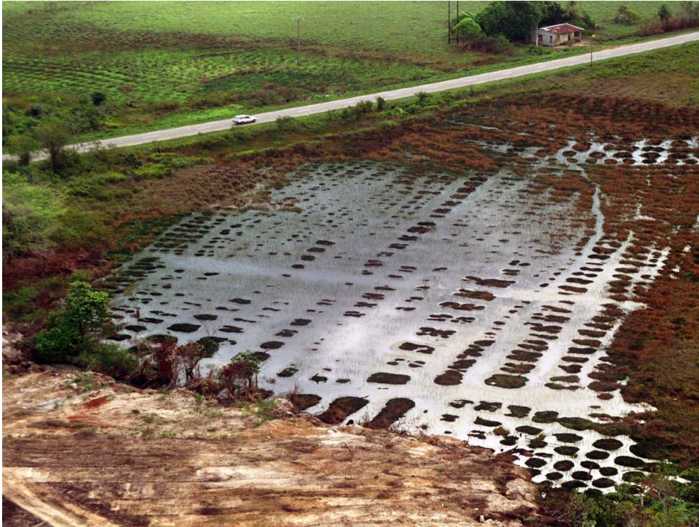
Figure 24 : Remblaiement de la savane inondable avec du sable provenant d'un chenier, près de Macouria, Guyane française
