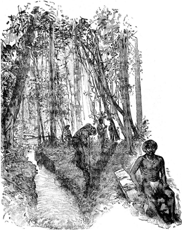
Figure 8 : Creusement d'un canal de dérivation par des orpailleurs en Guyane française
