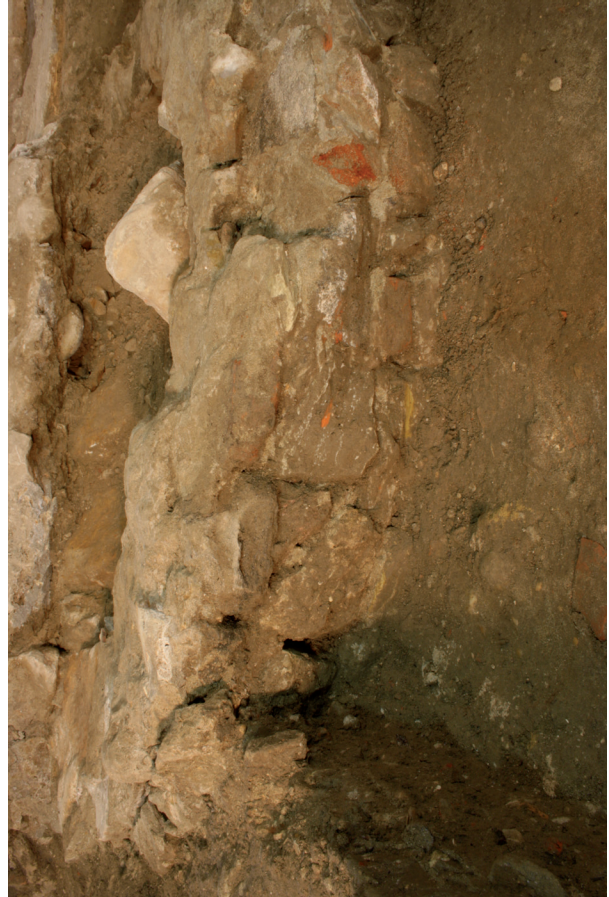
3. Vue de la maçonnerie du cuvelage (vue du nord)
