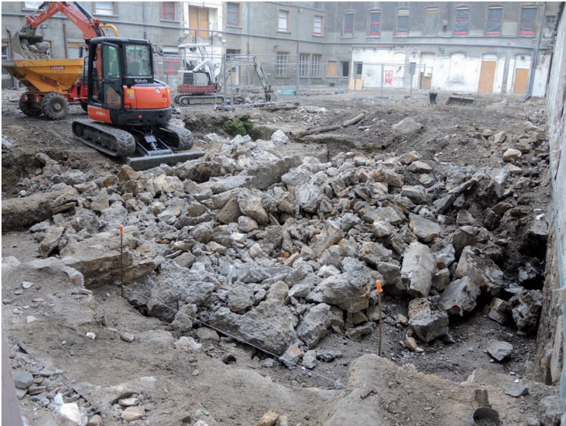
1. Vue générale de la cour du Magasin, en début de fouille, avec au fond la cave (vue du nord-est)
