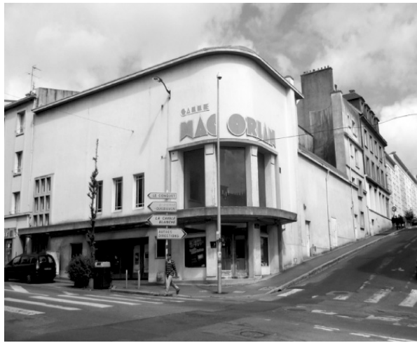
Photographie 1 : La réhabilitation de la salle Mac Orlan – Brest. Source : Solène Gaudin, 2009.
